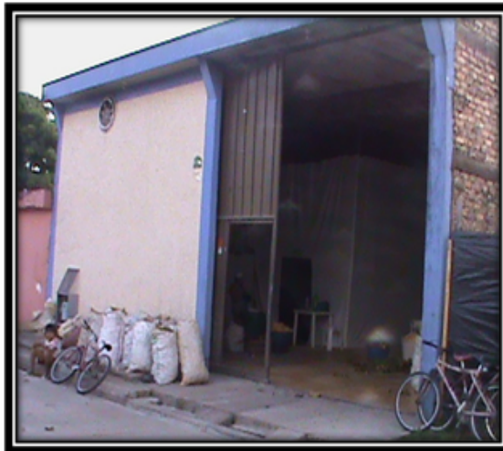
Foto 1 Entrada principal planta
