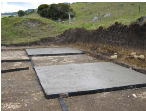
Figura 15. Fundición De Losa En Ajedrez
