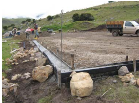
Figura 14. Fundición Viga De Amarre
