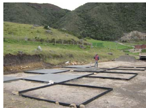
Figura 16. Fundición Losa Maciza
