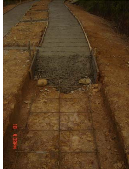
Figura 8. Fundicion Placa Huella
