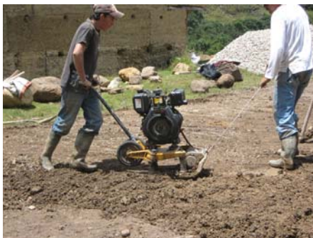
Figura 13. Compactación Con Vibrador
