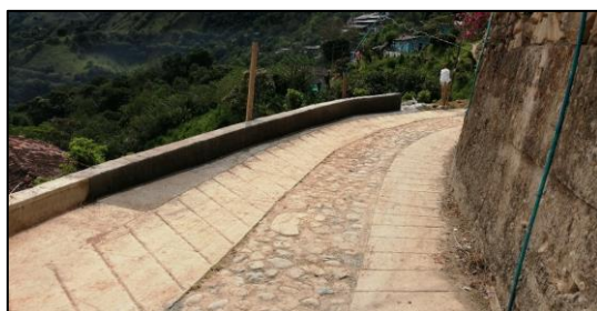
Figura 19. Muro de contención No 1
