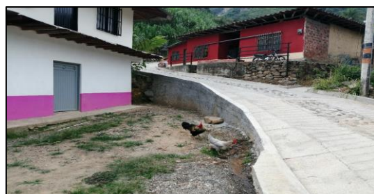
Figura 20. Muro de contención No 2
