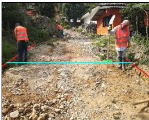
Figura 15. Nivelación transversal, marca sobre calandro indicando excavar. Abscisa K0+005m
