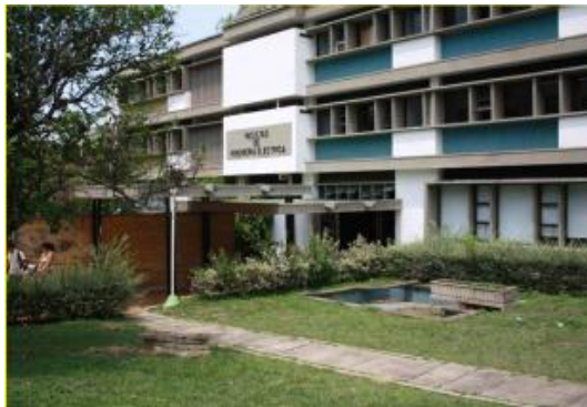
Figura 3. Infraestructura antigua de la E3T.
