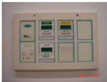
Figura 22: Sistema de alarmas gases medicinales
