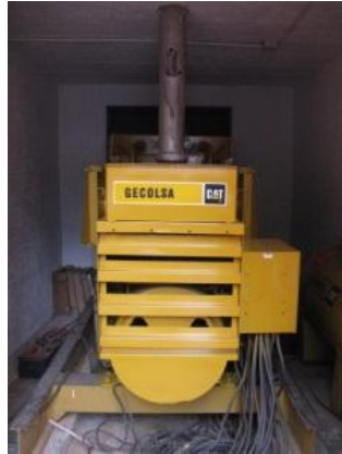
Figura 11: Planta eléctrica
