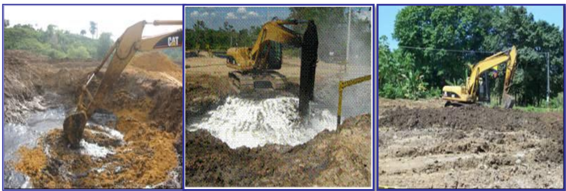
Figura 8. Procesos básicos de tratamiento de residuos aceitosos (mezcla con suelo limpio, aplicación de cal, homogenización y extendido).
