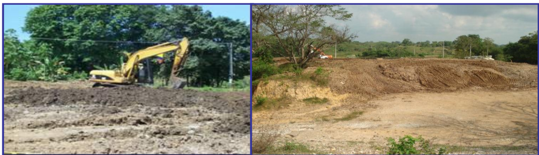
Figura 7. Acumulación de material en proceso de tratamiento en la zona.
