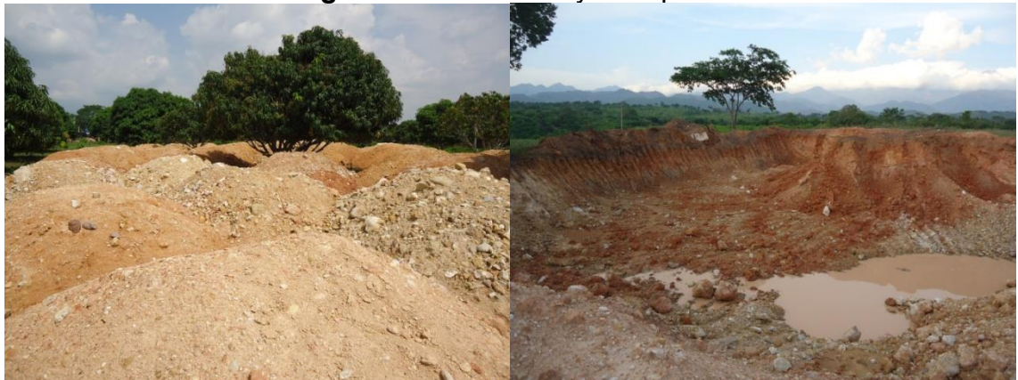
Figura 5. Excavación y transporte
