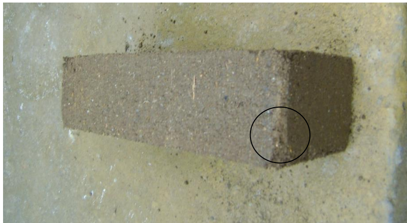
Figura 3. Falla en el acabado del BTC.
