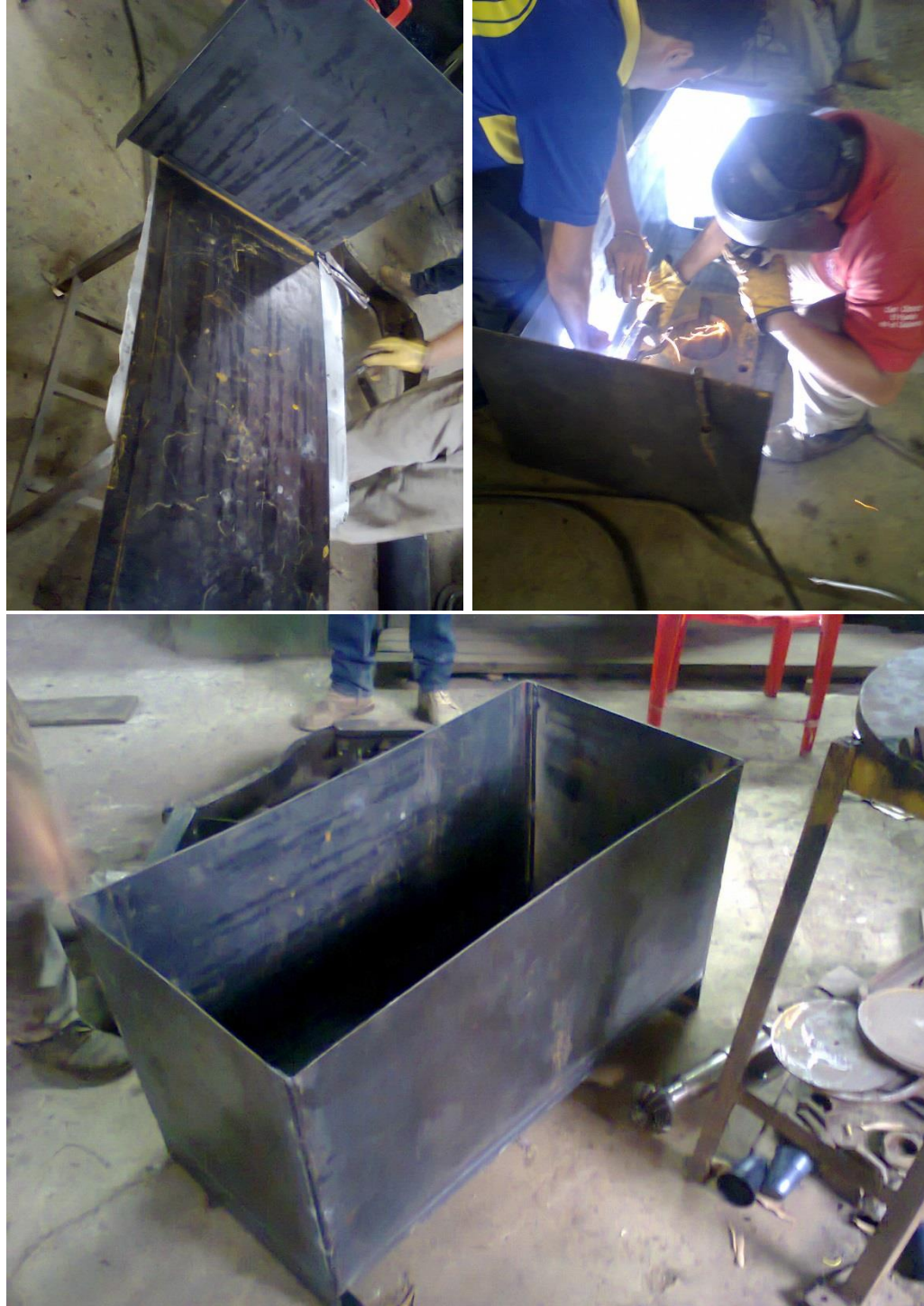
Figura 73. Construcción del tanque
