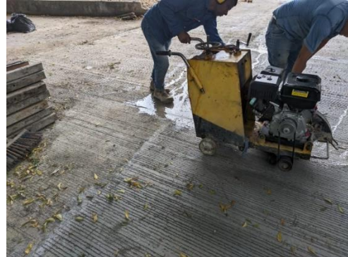
Figura 9. Corte y detalles del concreto hidráulico.
