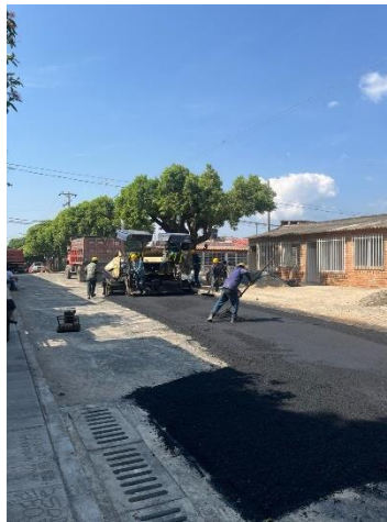
Figura 14. Instalación de MDC-19
