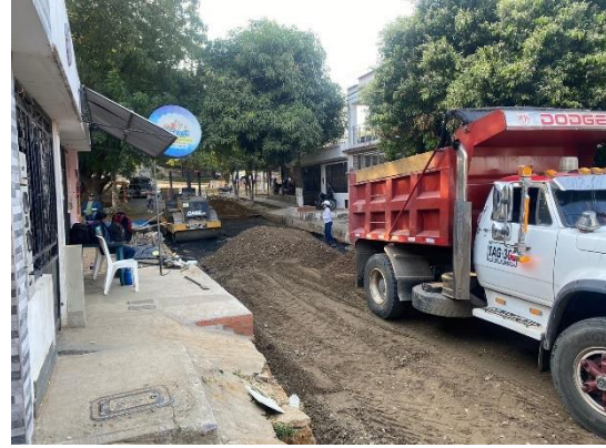
Figura 7. Instalación de la base granular.
