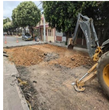
Figura 11. Demolición de pavimento asfáltico.
