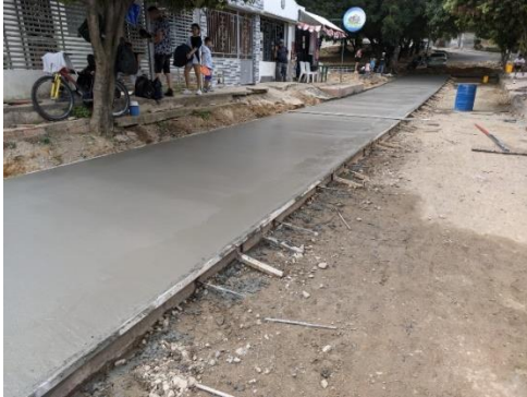
Figura 8. Instalación del concreto hidráulico.
