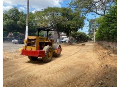
Figura 17. Compactación de la subrasante
