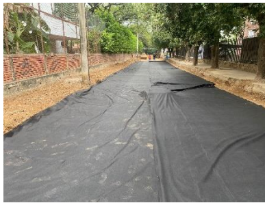
Figura 18. Instalación del geotextil.
