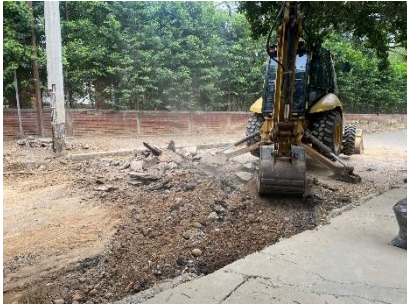
Figura 16. Demolición de carpeta asfáltica.
