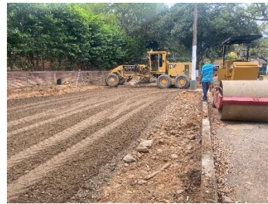
Figura 19. Nivelación de base.
