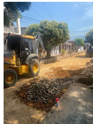
Figura 5. Instalación de pedraplén
