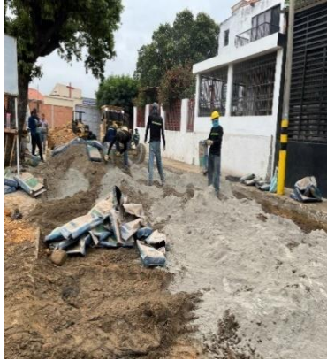
Figura 12. Instalación de base estabilizada con cemento.
