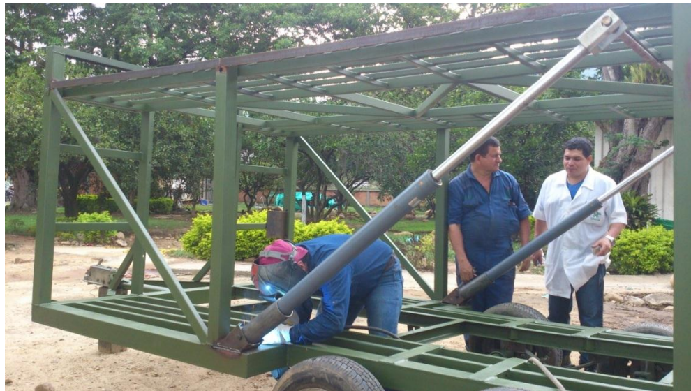
Figura 75. Soldadura base cilindros hidráulicos
