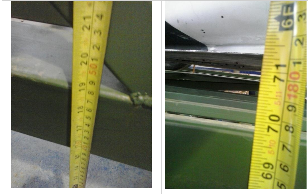
Figura 81. Medición primer y segundo nivel respectivamente
