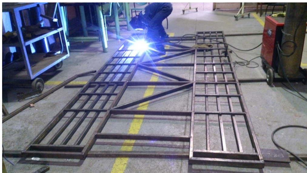
Figura 63. Soldadura fijación segundo nivel
