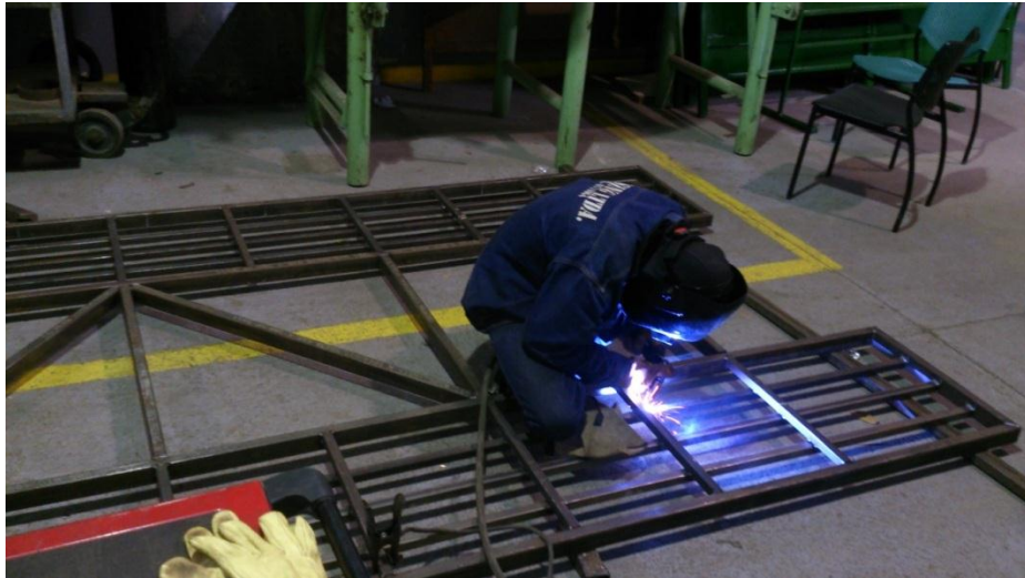
Figura 62. Soldadura sujeción segundo nivel
