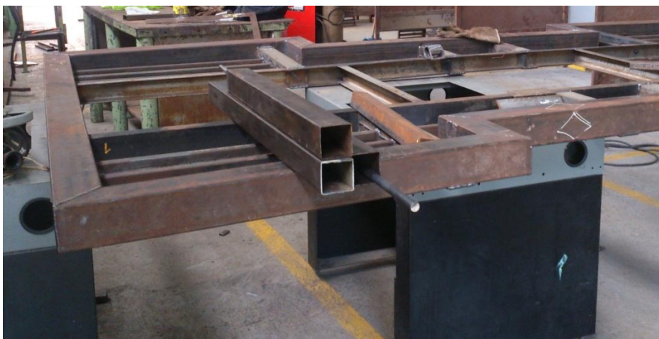
Figura 61. Soldadura primer nivel
