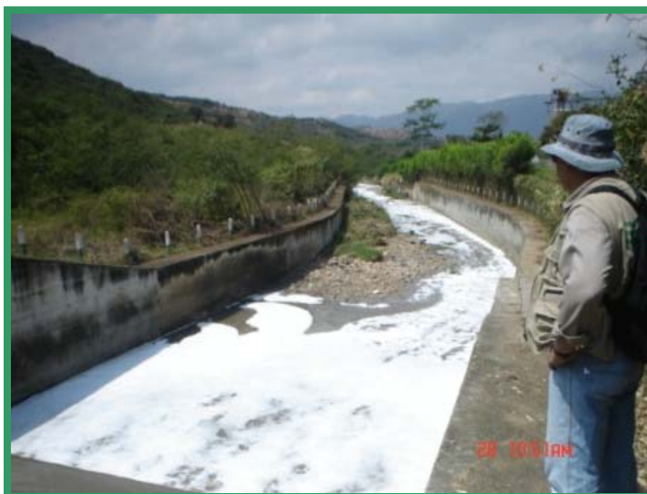
Figura 2. Canalización de la Quebrada La Iglesia
