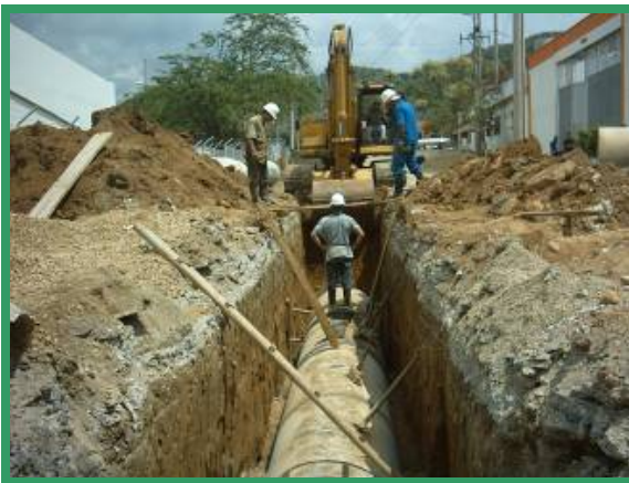
Figura 19. Alcantarillado pluvial Cra 16 Zona Industrial
