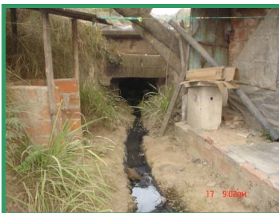
Figura 12. Entrega del Box Culvert calle 57 entre las cras 13 y 14
