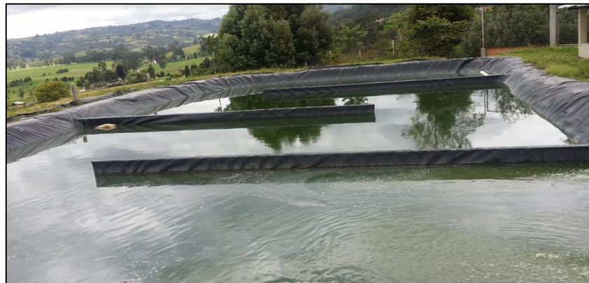
Figura 28. Material Sobrenadante en las Lagunas de Estabilización PTAR Sotaquirá
