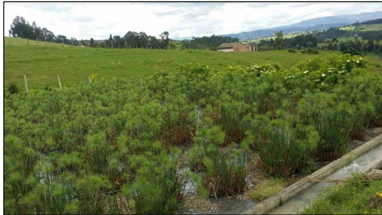
Figura 16. Humedal de Flujo Sub-Superficial de la PTAR de Sotaquirá
