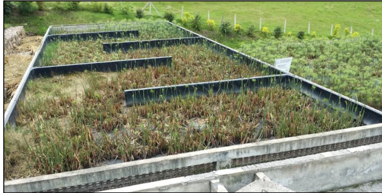
Figura 15. Humedal de Flujo Superficial de la PTAR de Sotaquirá
