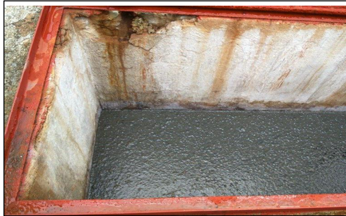
Figura 26. Nata Flotante – Tanque Imhoff PTAR Sotaquirá
