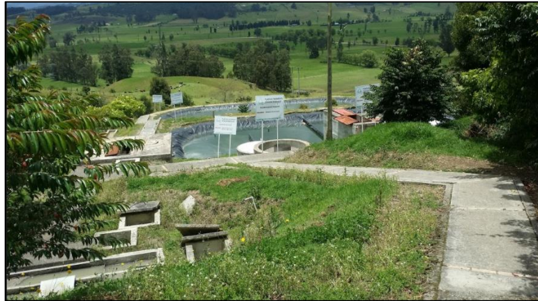
Figura 4. Vista General de la PTAR
