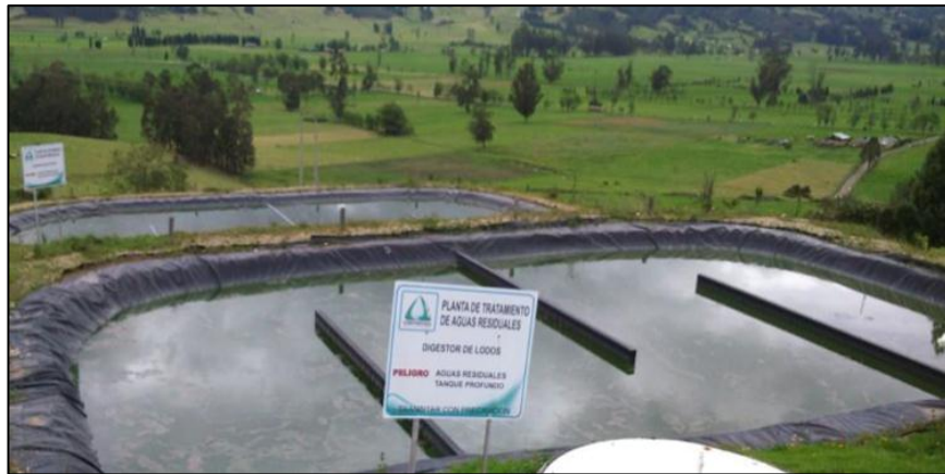
Figura 19. Laguna de Maduración de la PTAR de Sotaquirá
