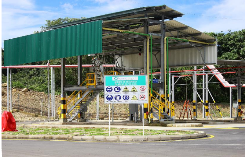
Figura 20. Llenadero de GLP (2 bahías) y Diluyente 1A (2 bahías).
