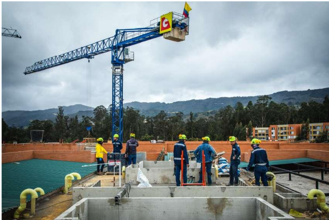
Izaje de elementos en Andarrios
