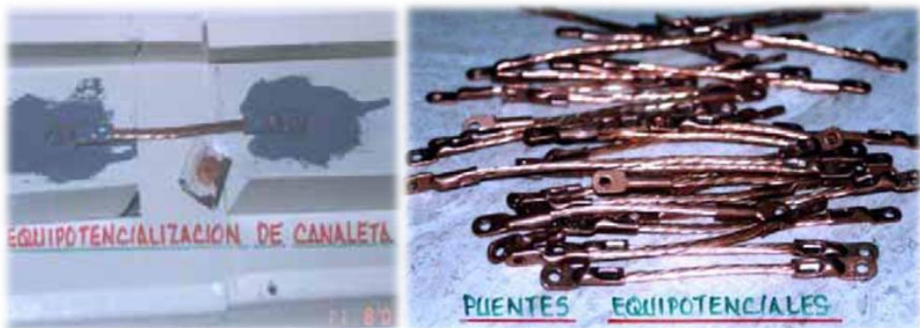
Fotografía 10 Equipotencialización de la canaleta
