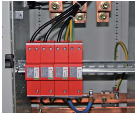
Figura 32 DPS clase I, descargador de corrientes de rayo para tensiones nominales de 400 y 690 V Fuente: Catalogo Dehn “Líneas de Energía” pág. 27
