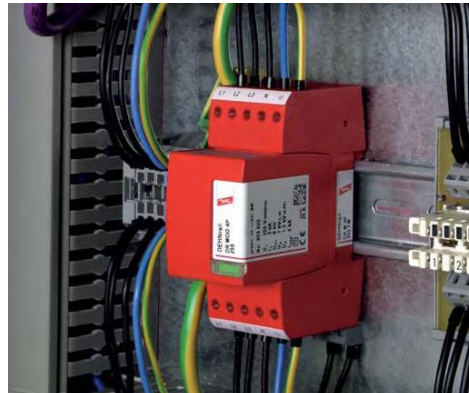
Figura 34 DPS clase III, descargador de sobretensiones Fuente: Catalogo Dehn "Líneas de Energía" pág. 55
