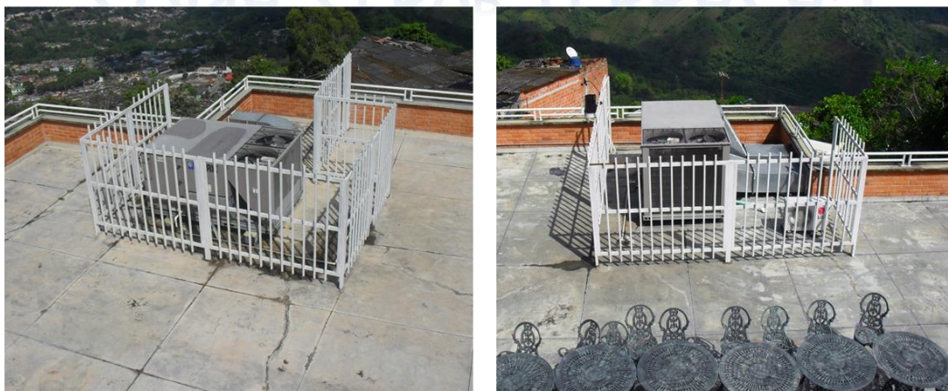
Fotografía 4 Elementos encontrados en las terrazas del segundo piso
