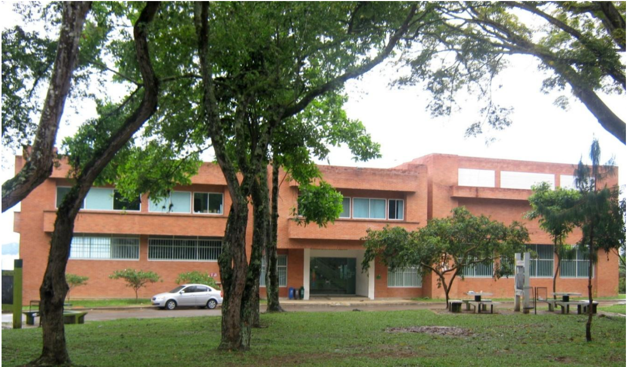
Fotografía 1 Fachada principal Caracterización de materiales “Álvaro Beltrán Pinzón”
