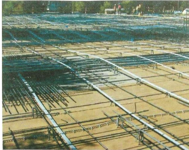
Figura 8. Losa maciza plana postensada antes de la fundida
