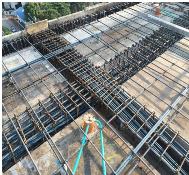
Figura 35. Construcción de losas postensadas proyecto No.6
