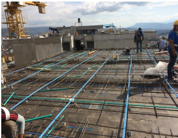
Figura 41. Construcción de losas postensadas proyecto No.9
