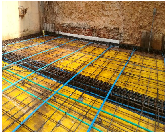
Figura 29. Construcción de losas postensadas proyecto No.3
