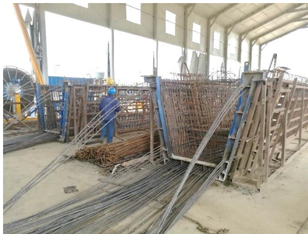
Figura 2. Banco de tensionamiento y armado para vigas pretensadas
