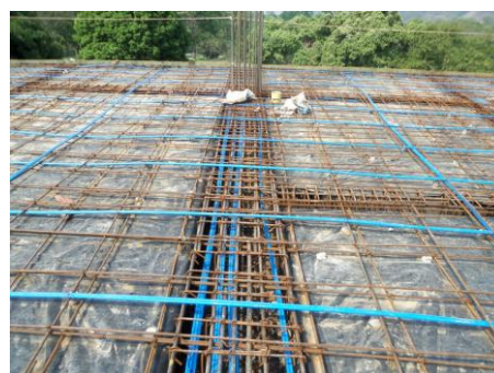
Figura 25. Construcción de losas postensadas edificio No. 1
