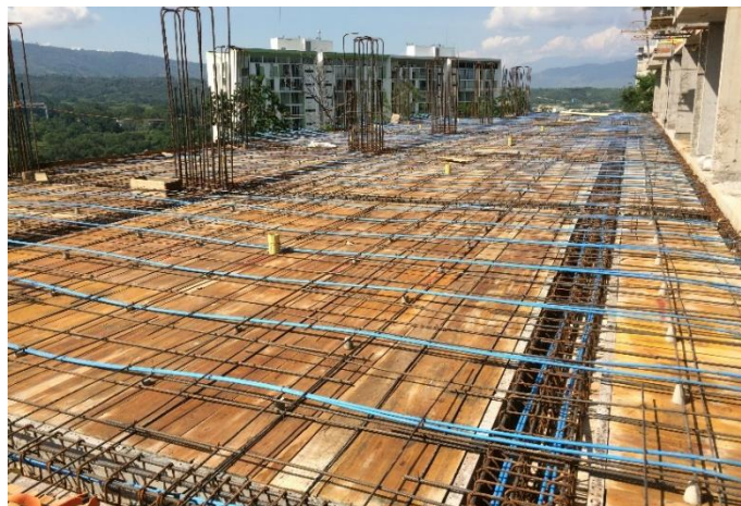
Figura 11. Losa con vigas postensadas antes de fundida
