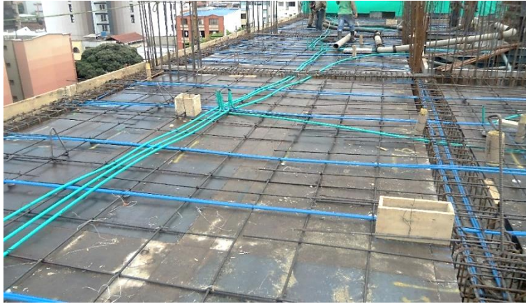
Figura 6. Losa maciza con postensado no adherido
