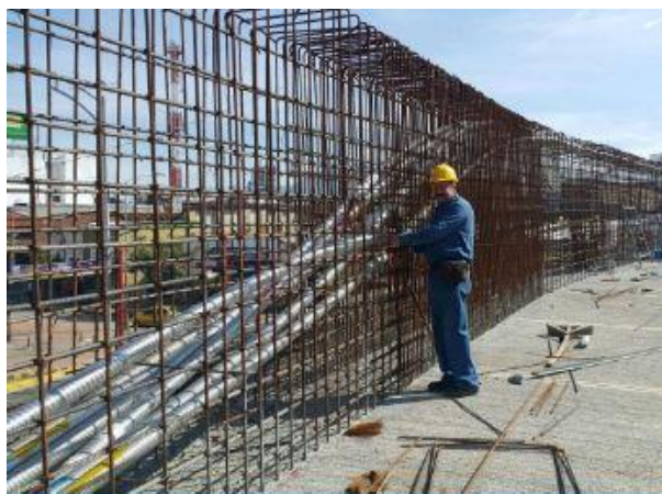
Figura 5. Vigas de puentes con postensado adherido
