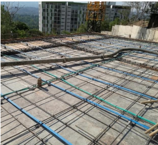
Figura 39. Construcción de losas postensadas proyecto No.8
