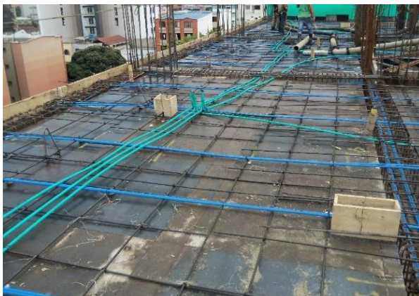
Figura 33. Construcción de losas postensadas proyecto No.5
