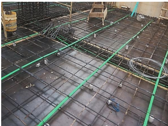
Figura 31. Construcción de losas postensadas proyecto No.4
