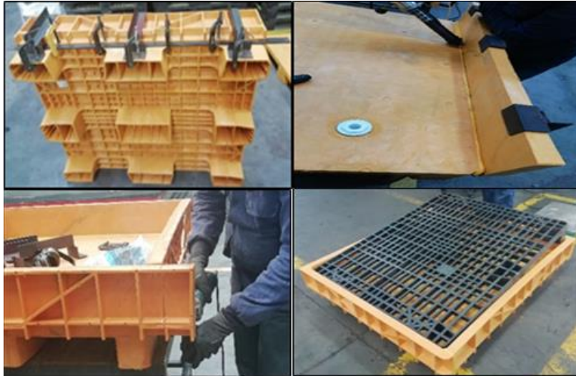
Figura 7. Proceso por soldadura plástica
