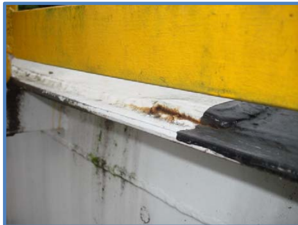
Fotografía 8 Soldaduras del anillo superior tanque K – 02
