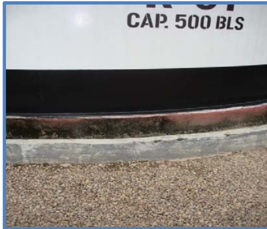
2b) Vista del anillo perimetral del Tanque K - 02
