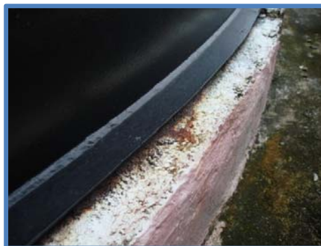
2a) Vista del anillo perimetral del Tanque K – 01
