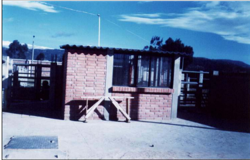
FOTO 3. Construcción caseta. Matadero municipal
