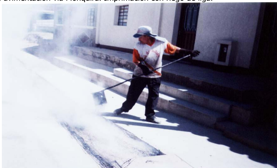
FOTO 11. Pavimentación vía Monquirá. Imprimación con riego de liga.
