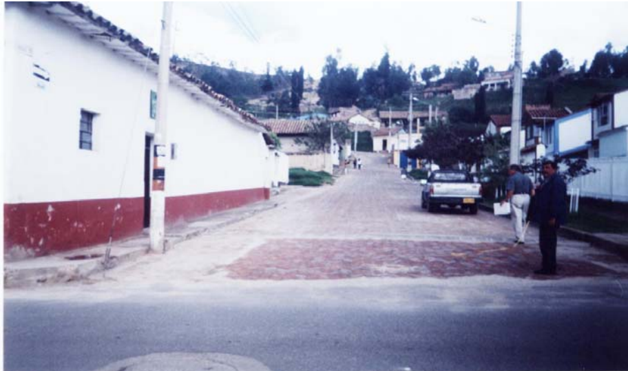
FOTO 7. Se observa la reparación de adoquín calle 15 entre 9 y los alpes.
