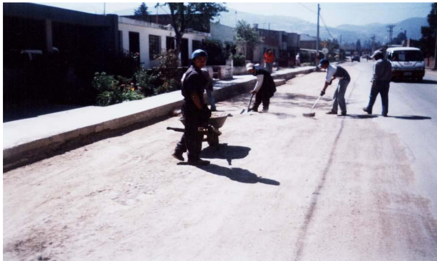
FOTO 10. Pavimentación vía Monquirá. Limpieza para luego proceder a imprimación con el riego de liga
