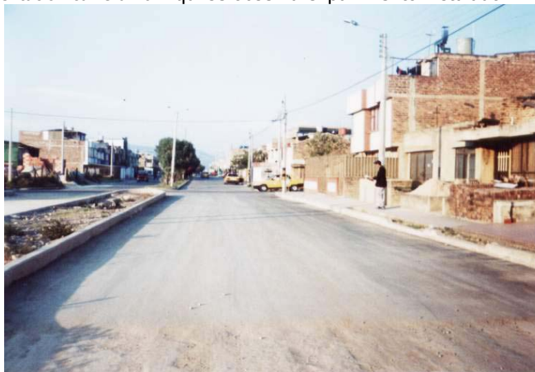
FOTO 8. Pavimentación carrera 20. Aquí se observa el pavimento instalado
