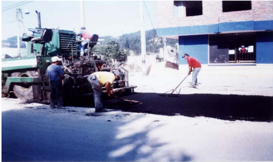
FOTO 12. Pavimentación vía Monquirá. Extendido de mezcla asfáltica tipo rodadura con finisher.
