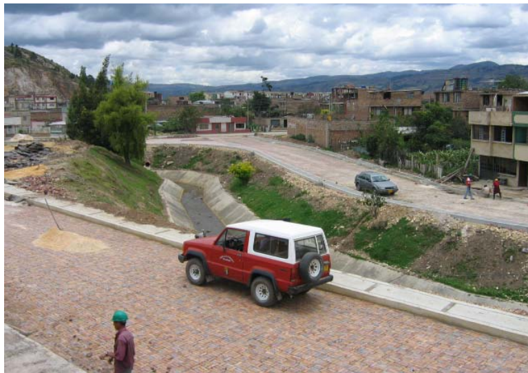
FOTO 14. Paralelas al Río Monquirá. Instalación de adoquín costado izquierdo.
