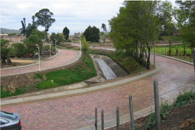
FOTO 14. Paralelas al Río Monquirá. Obra culminada. Pavimento articulado
