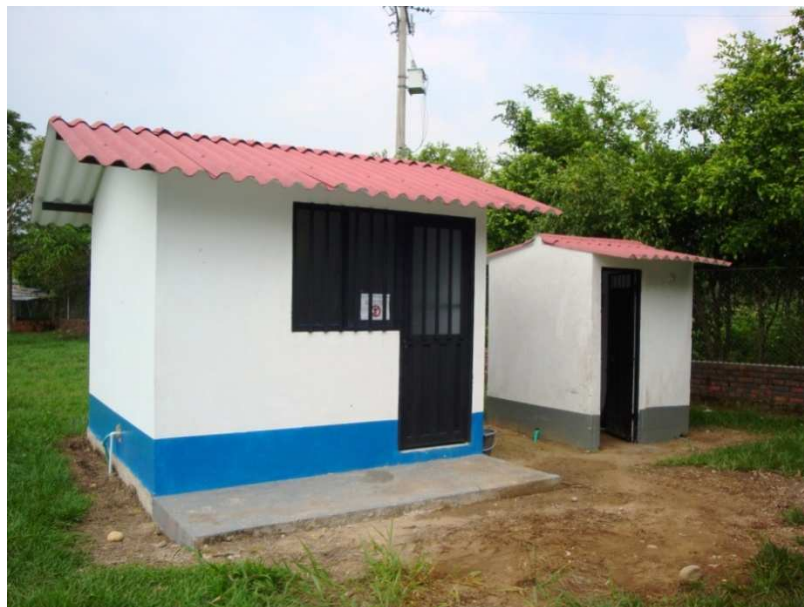
Figura 7. Caseta del laboratorio
