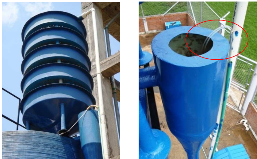
Figura 10. Bandejas de aireación y cono de mezcla rápida
