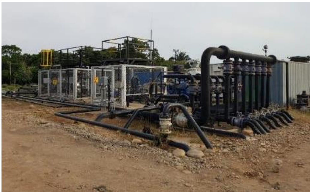
Figura 10. Medidores multifásicos locación Ceibo.
