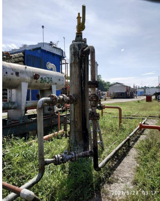
Apéndice A. Torre de separación vista desde el este.
