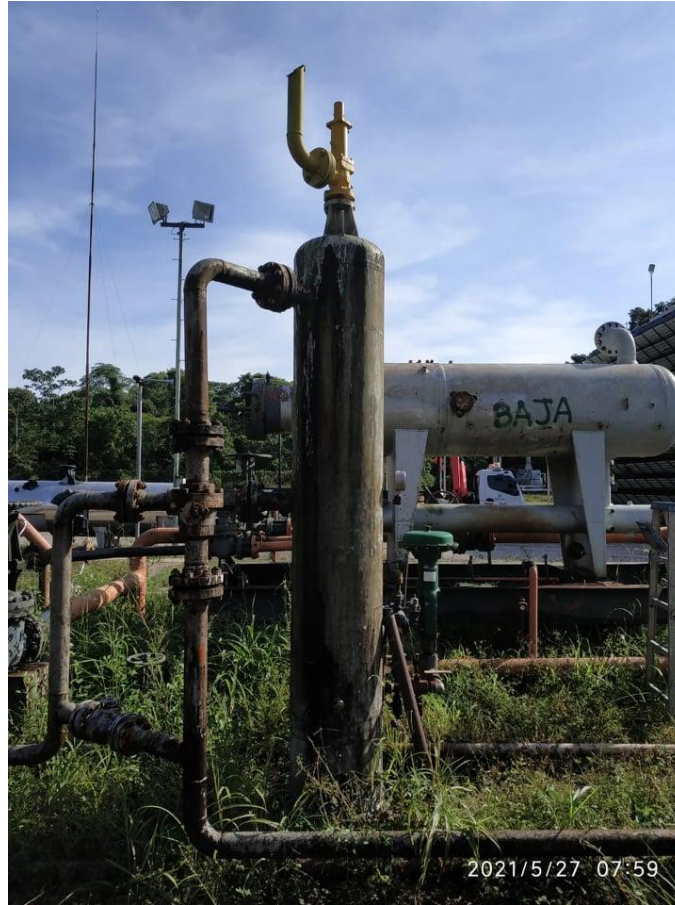
Apéndice C. Torre de separación vista desde el sur.
