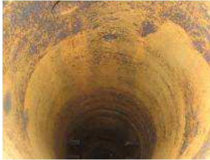
Figura 31. Estado interno de la Despojadora D2
