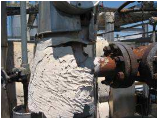
Figura 39. Estado del MCO-T cerca a la brida de alimentación de la torre despojadora de Acpm
