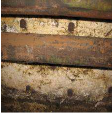
Figura 21b. Pared lateral con refractario resquebrajado
