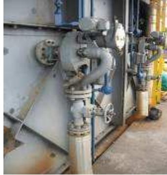
Figura 25. Vista externa del sistema de Deshollinado
