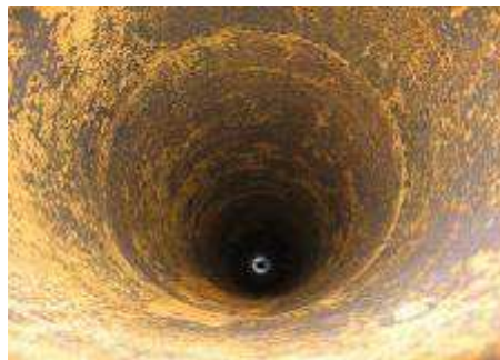
Figura 34. Estado interno de la Despojadora D3
