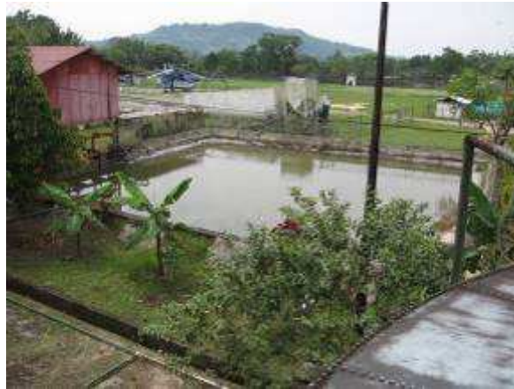
Figura 64. Pozo de reposo de agua industrial refinería orito putumayo
