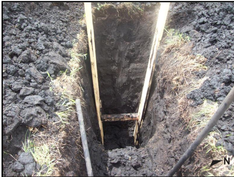
FIGURA 66 Panorámica de Trinchera-2, donde se muestra el entibado de las paredes.
