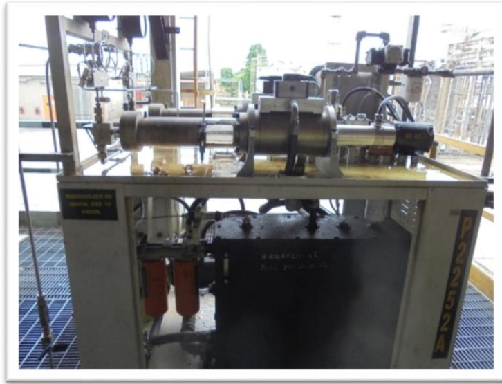
Figura 10. Bomba de inyección de iniciadores Polietileno II
