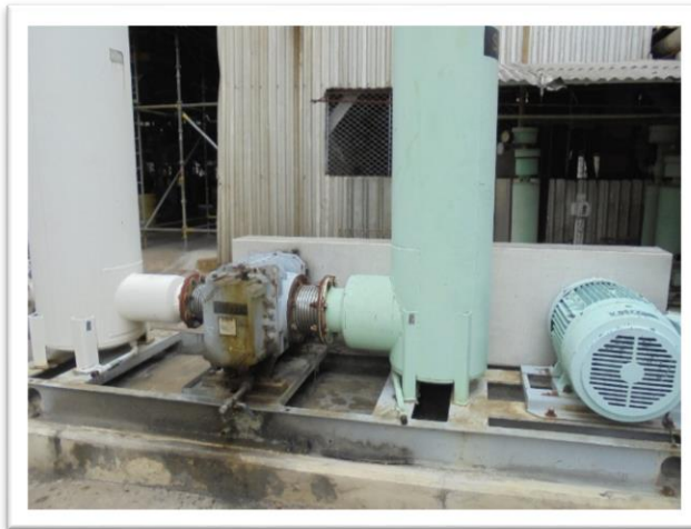
Figura 18. Soplador (compresor de lóbulos) Polietileno II
