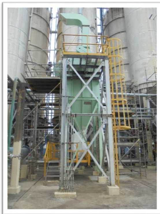
Figura 20. Colector de polvo (pelusa) Polietileno II
