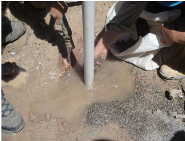
Hidratación del sello de bentonita.
