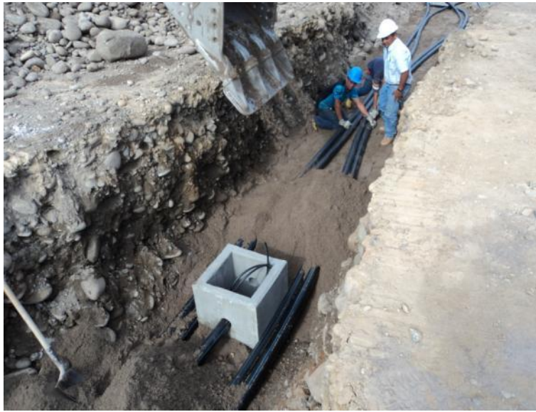
Cubrimiento de la tubería de polietileno con arena.
