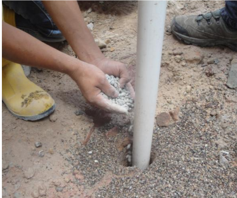
Realización del Sello de Bentonita.
