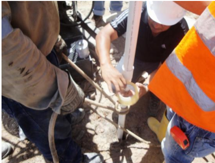
Recubrimiento de la unión con cinta en tubería de PVC.
