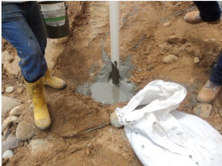
Lechada aplicada en sistema Dex-Brs.
