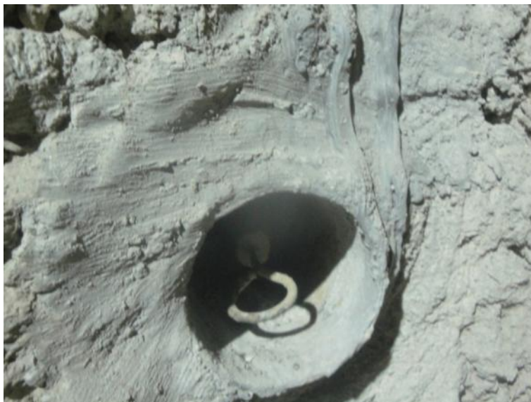
Aspecto de una Argolla de convergencia instalada.
