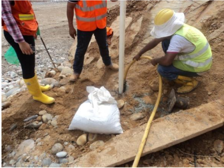
Inyección de lechada en sistema Dex-Brs.
