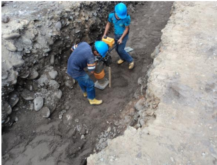
Compactación del terreno con máquina liviana.
