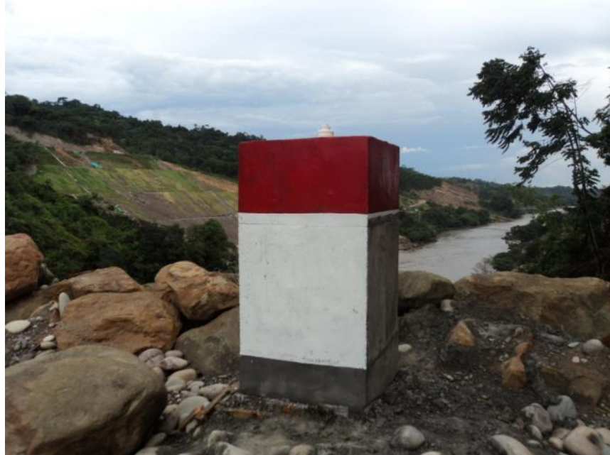
Figura 3. Mojón de control ubicado en los llenos de la presa.
