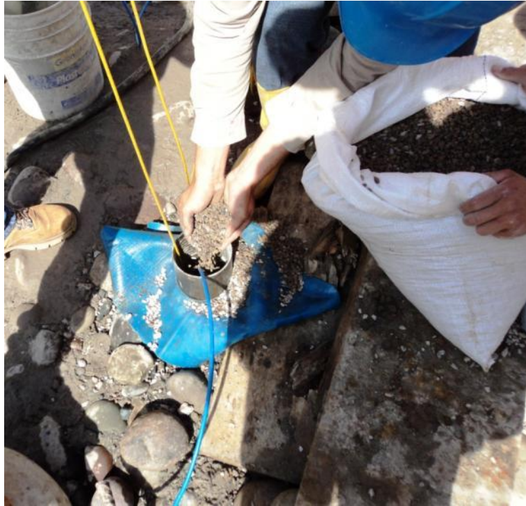
Base de material granular para ubicar el instrumento.
