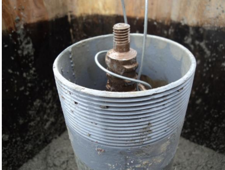
Tornillo o base de anclaje del prisma reflectante del mojón de control.
