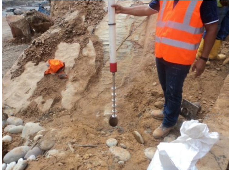
Anclaje en roca sistema Dex-Brs.
