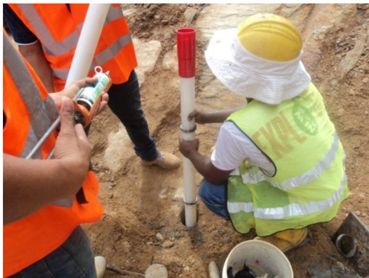
Anillos magnéticos de referencia sistema Dex-Brs.
