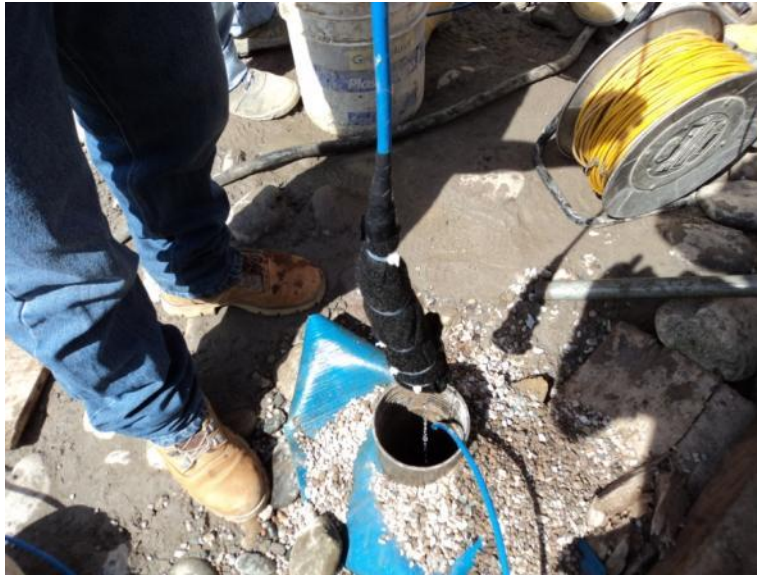
Introducción del instrumento en la perforación.
