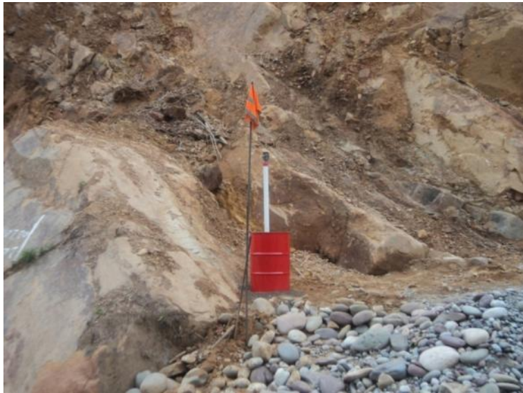
Protección provisional al sistema Dex-Brs.
