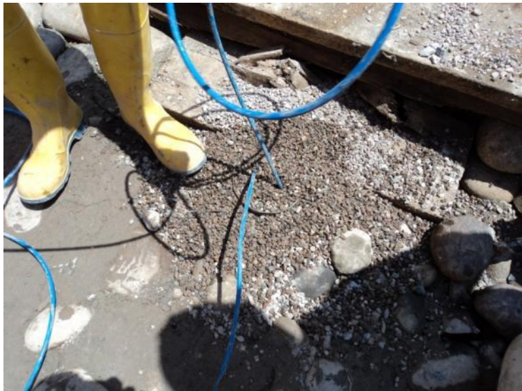
Aspecto final de Perforación cubierta hasta la superficie.
