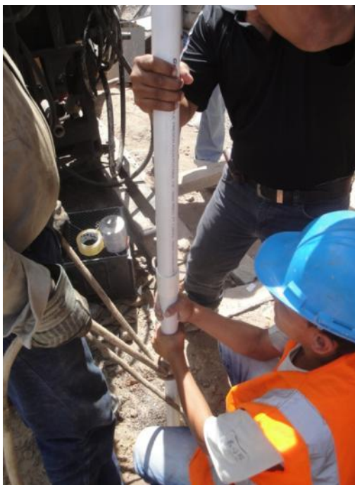
Prolongación de tubería en el sondeo.
