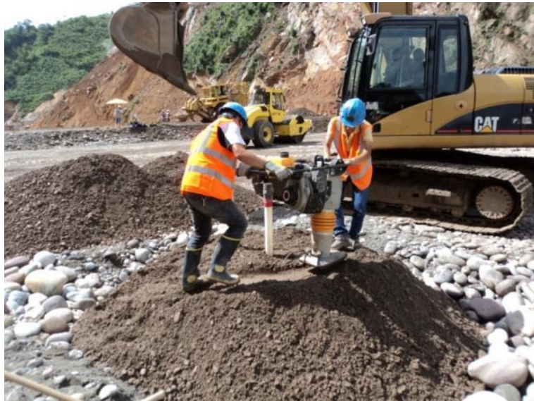
Compactación del relleno para el sistema Dex-Brs.
