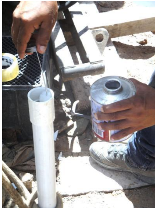
Aplicación de Soldadura PVC en los extremos a unir del tubo
