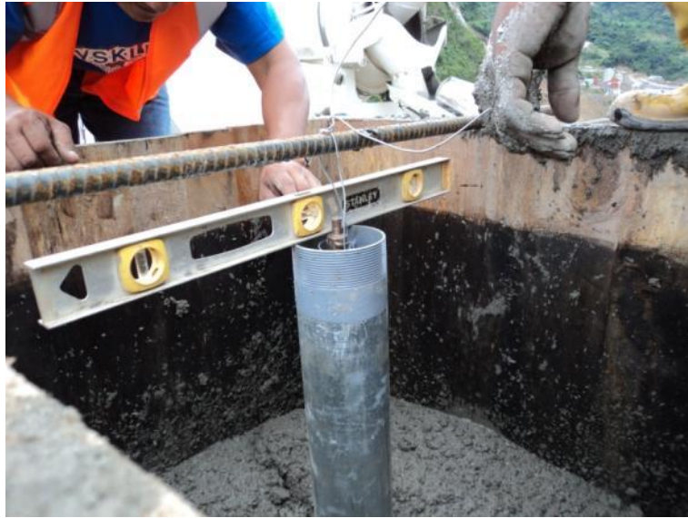
Nivelación horizontal del cilindro metálico del mojón de control.
