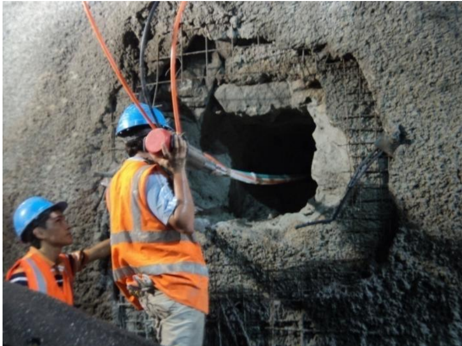
Ubicación del extensómetro de posición múltiple en la perforación.
