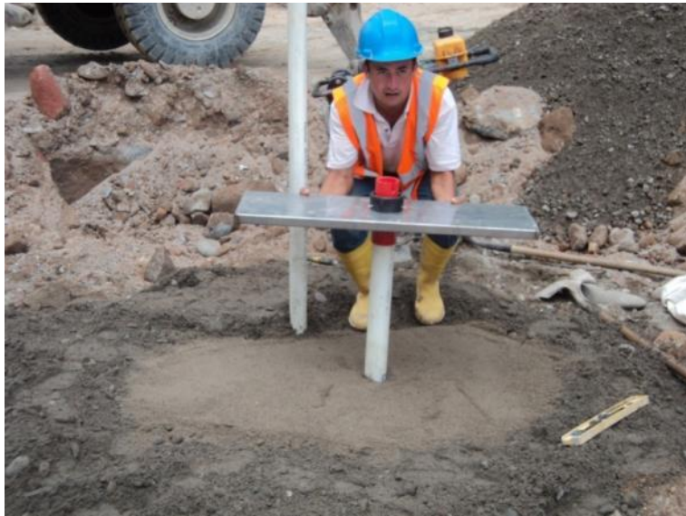
Introducción de la placa en la tubería del sistema Dex-Brs.
