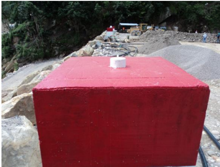
Punta metálica del mojón de control.
