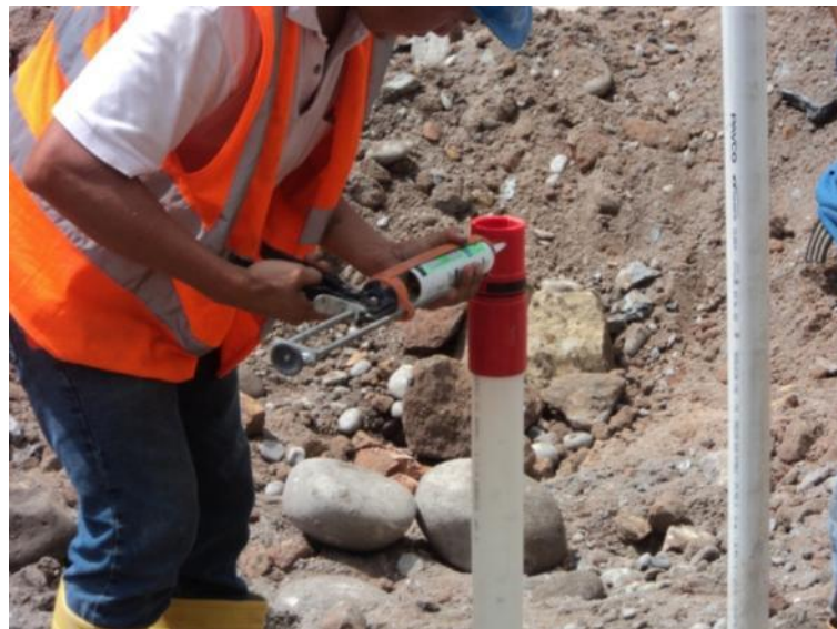
Aplicación silicona líquida a la junta telescópica del sistema Dex-Brs.
