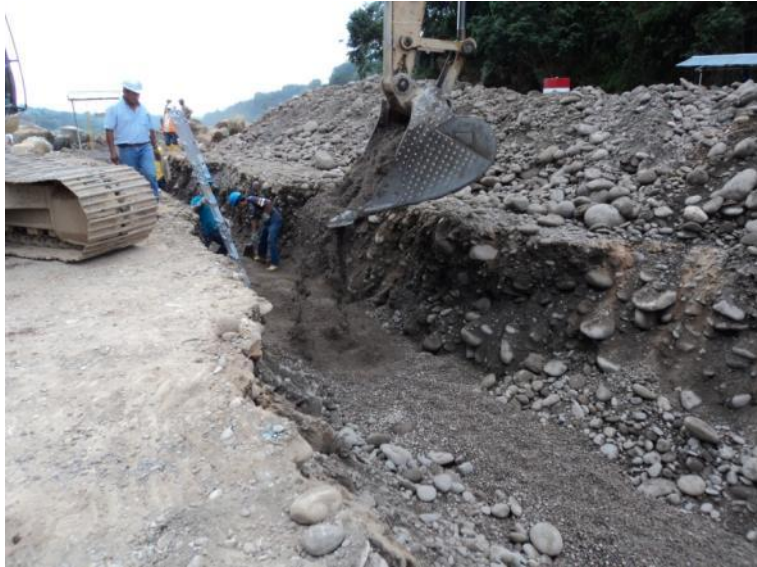
Disposición de la capa de arena.
