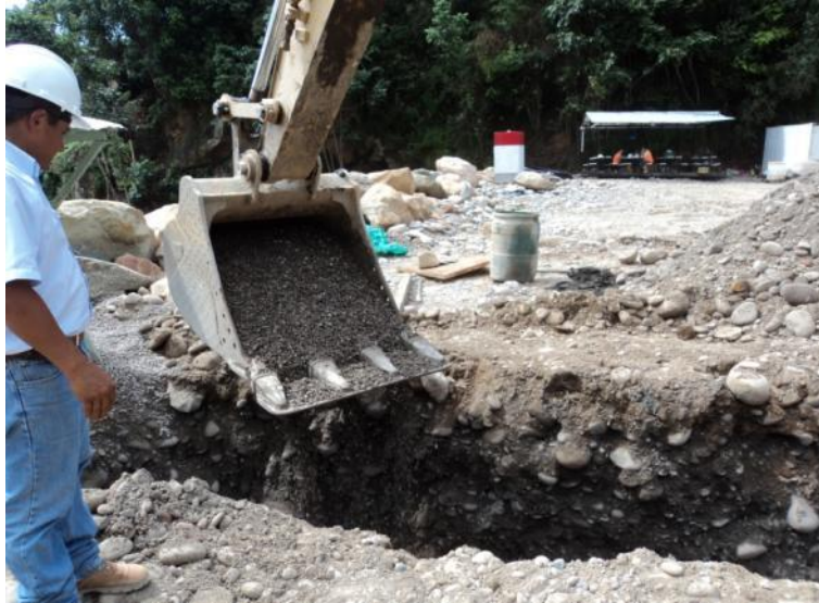
Zanja para la instalación de la tubería de conducción del cableado y los ductos hidráulicos de las celdas de asentamiento.
