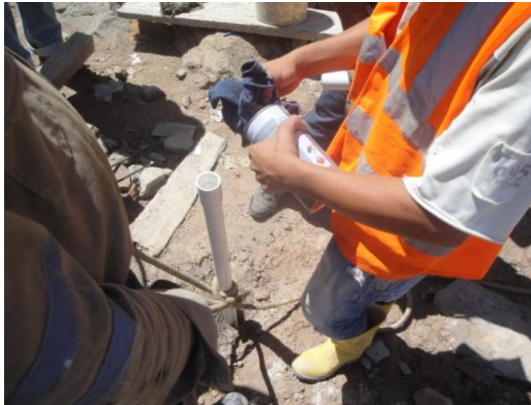
Limpieza de los extremos a unir con Limpiador para tubería PVC.
