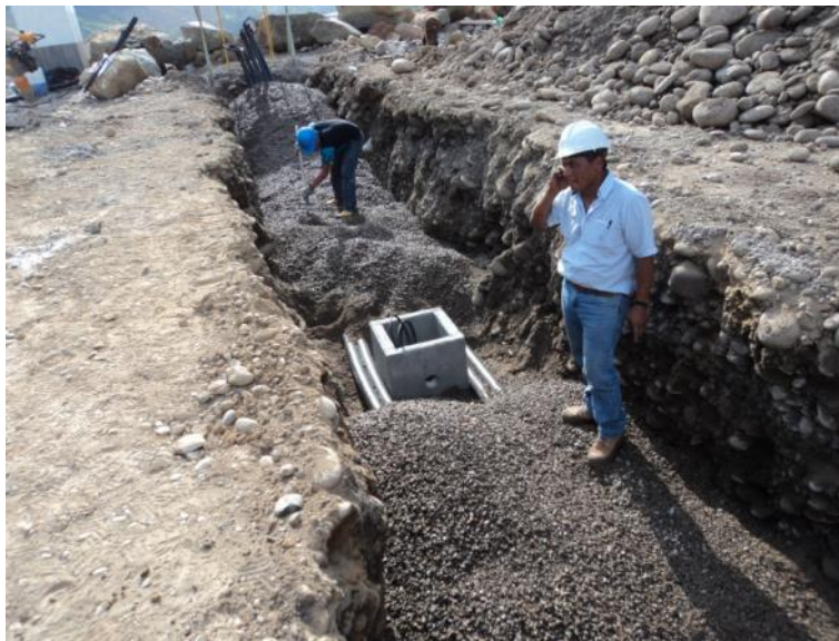
Aspecto de la zanja con Segunda capa de grava aplicada.
