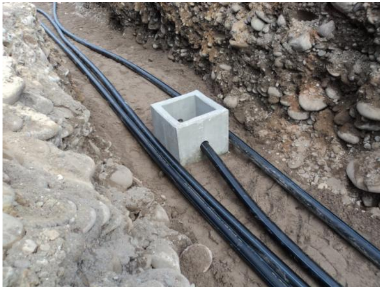
Tubos de polietileno en la arqueta.
