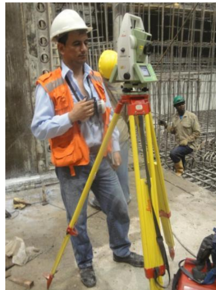
Estación de topografía para medir los desplazamientos según los mojones.
