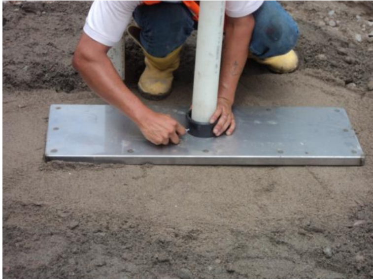
Fijación de la placa a la tubería del sistema Dex-Brs.
