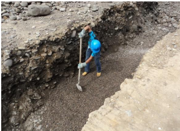
Colocación de la primera capa de grava.
