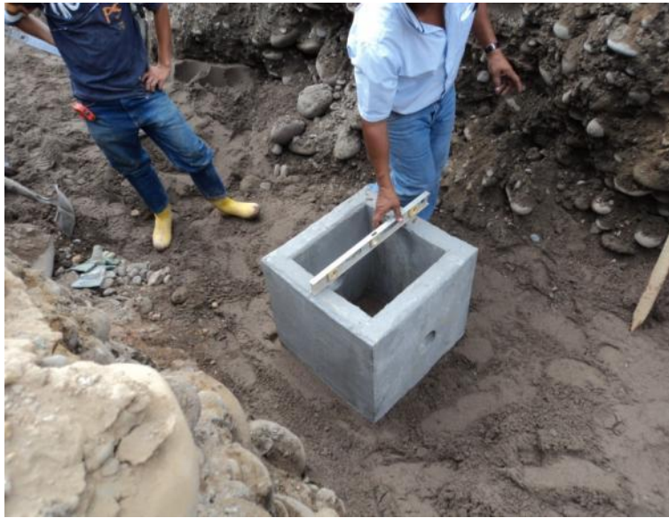
Nivelación de la arqueta de protección.
