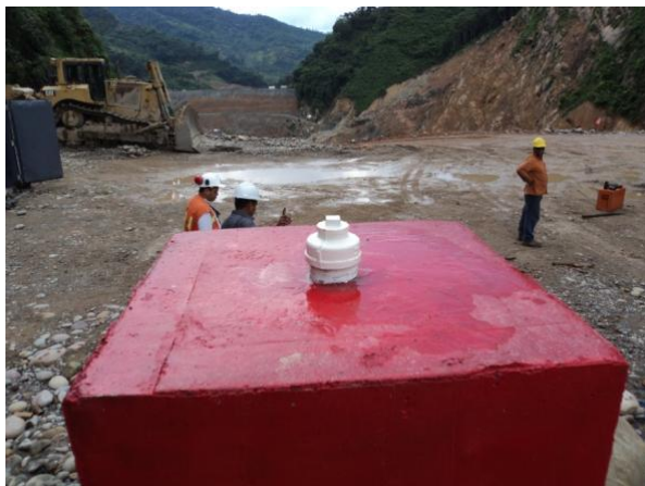
Recubrimiento de la punta metálica del mojón de control.
