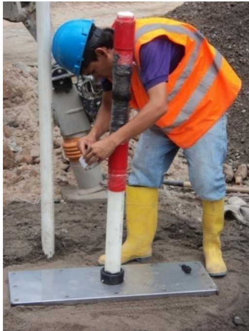
Protección de la junta telescópica del sistema Dex-Brs. con cinta Adhesiva.
