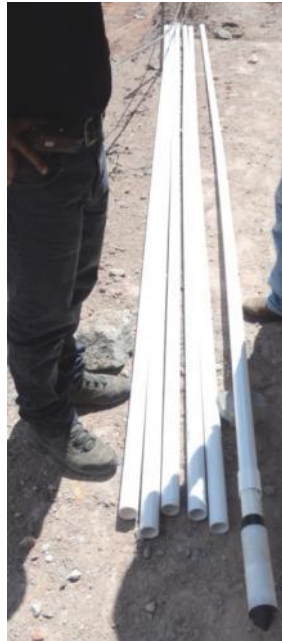
Figura 10. Piezómetro abierto.
