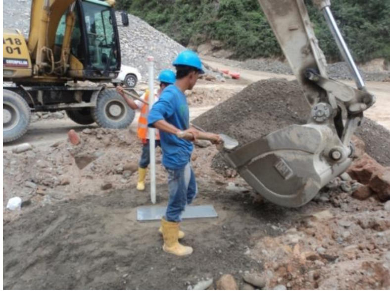
Cobertura de la placa metálica del sistema Dex-Brs.
