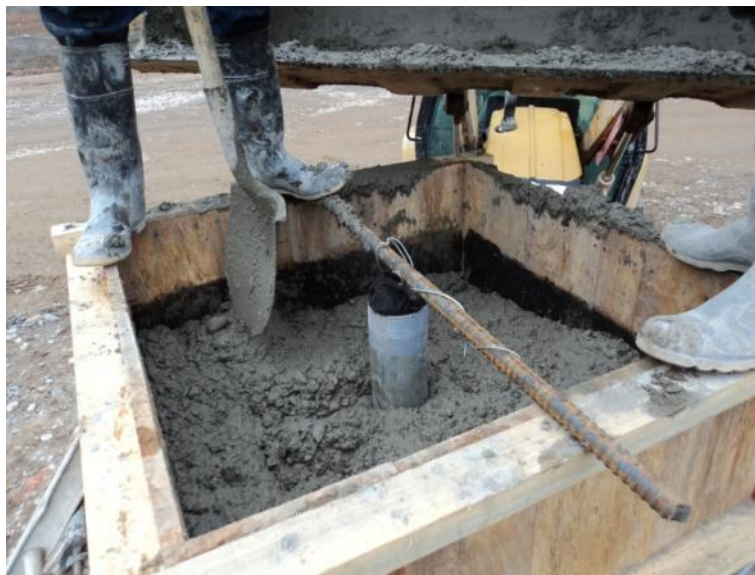
Fundición del mojón de control.
