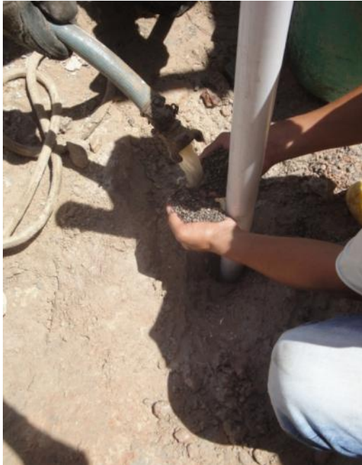
Llenado del espacio entre la tubería y la perforación con arena gruesa.
