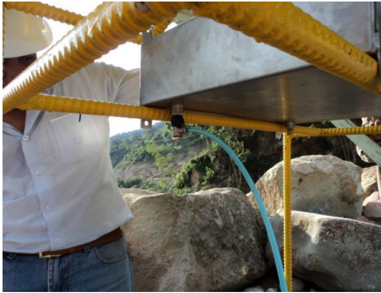
Conexión de las líneas hidráulicas al tanque de referencia (Reservorio).
