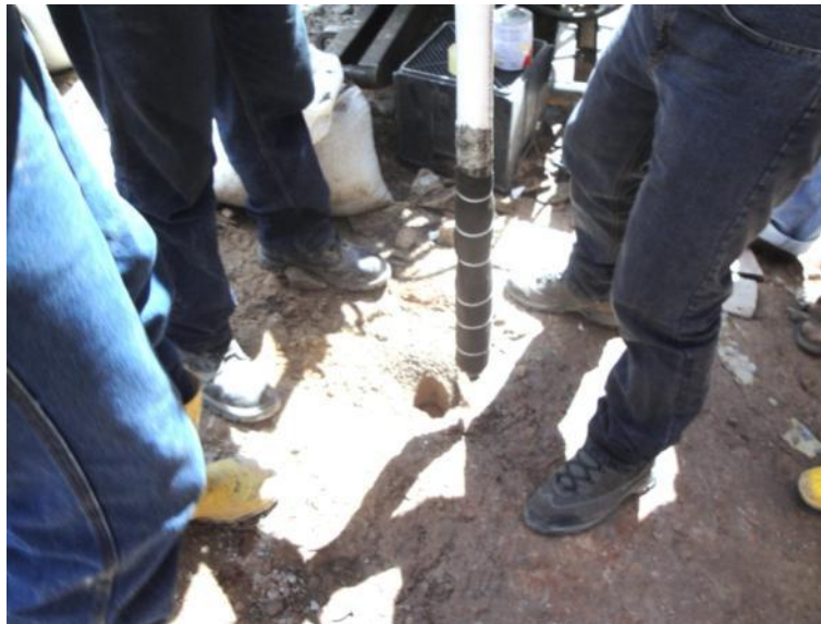
Recubrimiento del filtro piezométrico con geotextil.
