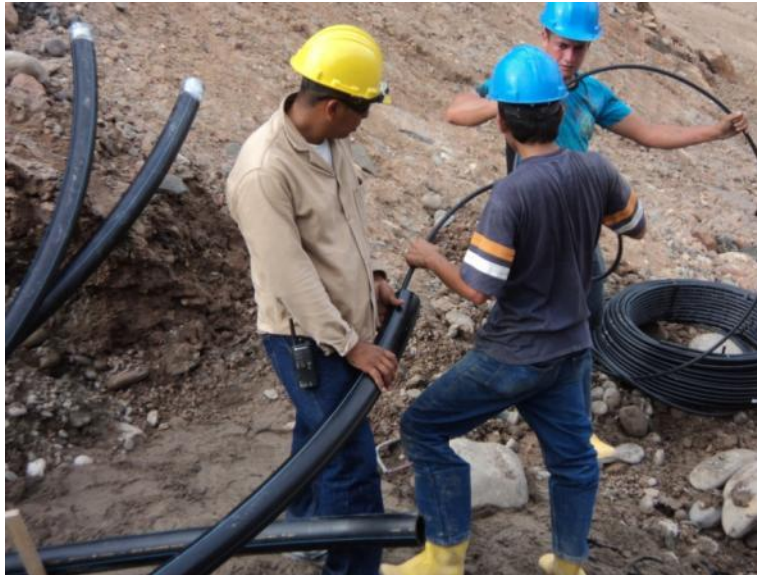
Introducción de los ductos hidráulicos y los cables eléctricos en la tubería de polietileno.
