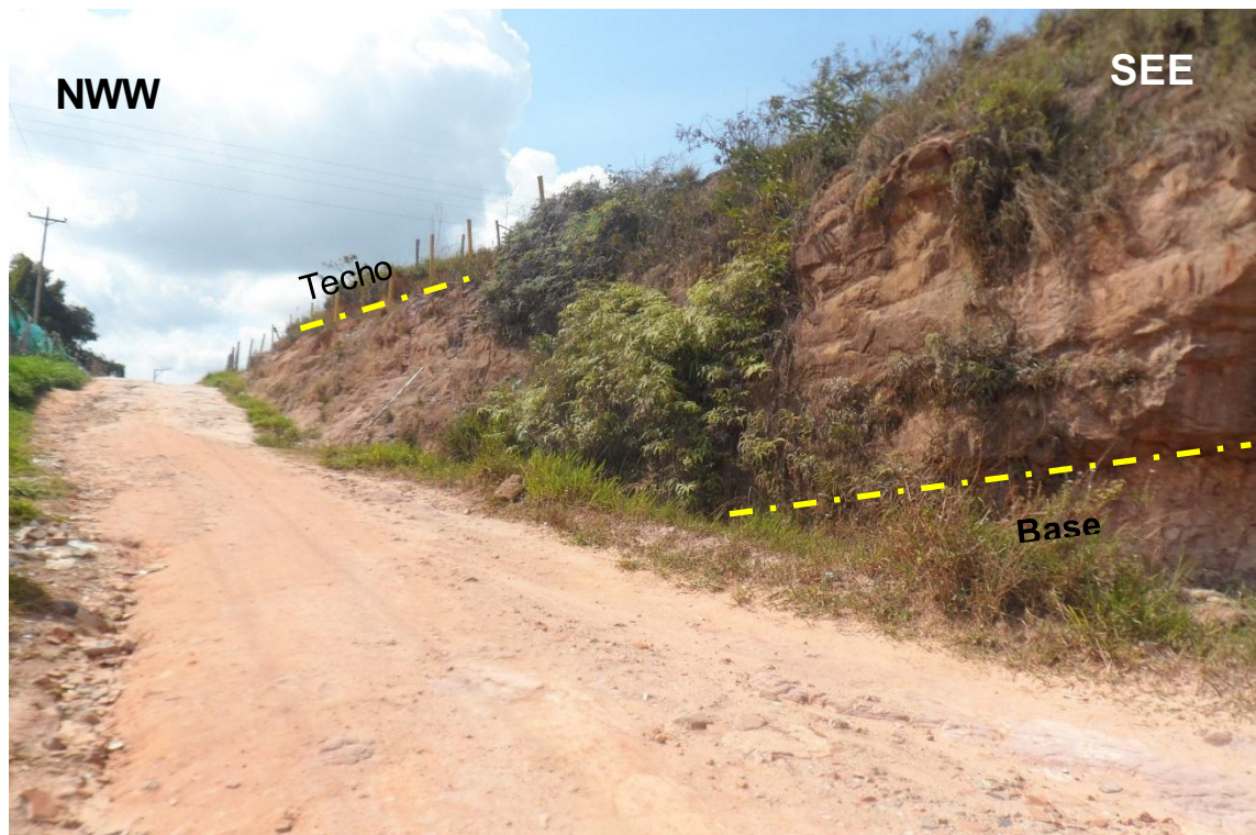
Figura 29. Base y techo del segmento 8 de la columna Guatiguará.
