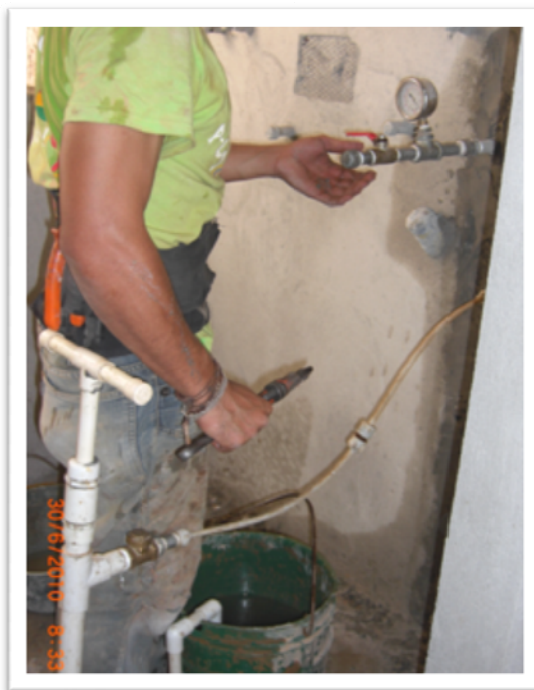
Figura 24. Prueba de Presión Hidráulica
