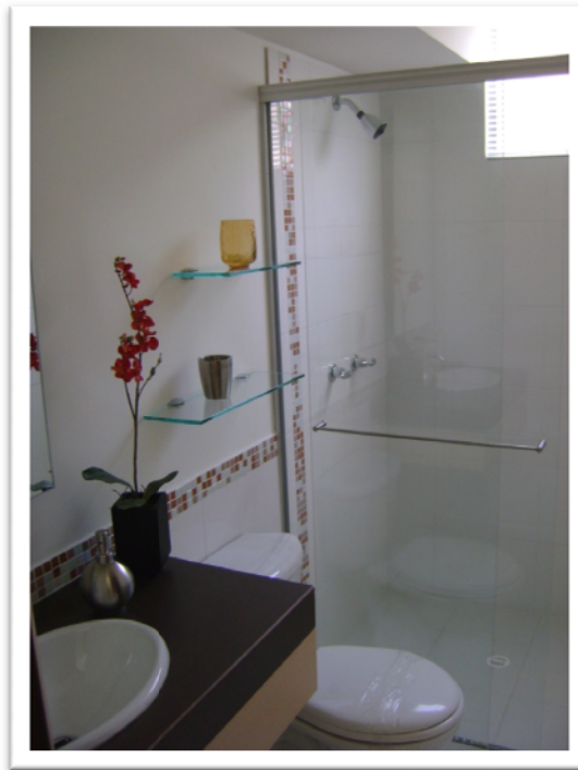
Figura 9. Aparatos sanitarios en baño auxiliar
