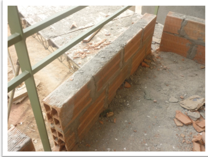
Figura 3. Mampostería en ladrillo H-10
