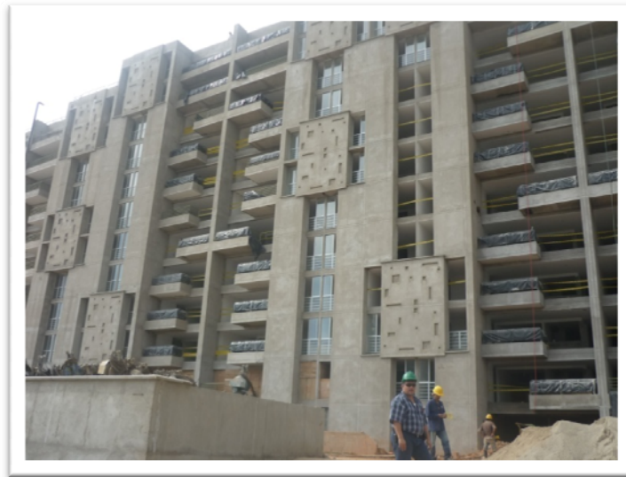
Figura 5. Estructura tipo Outinord o Túnel para torres
