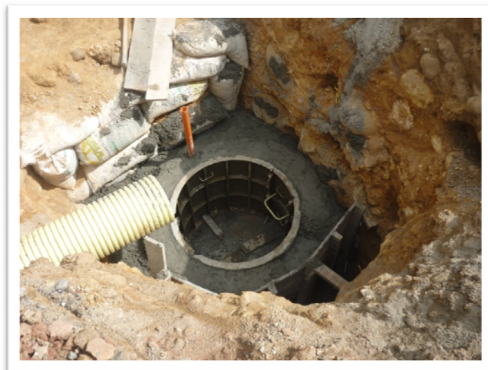
Figura 13. Pozo de inspección red de alcantarillado.
