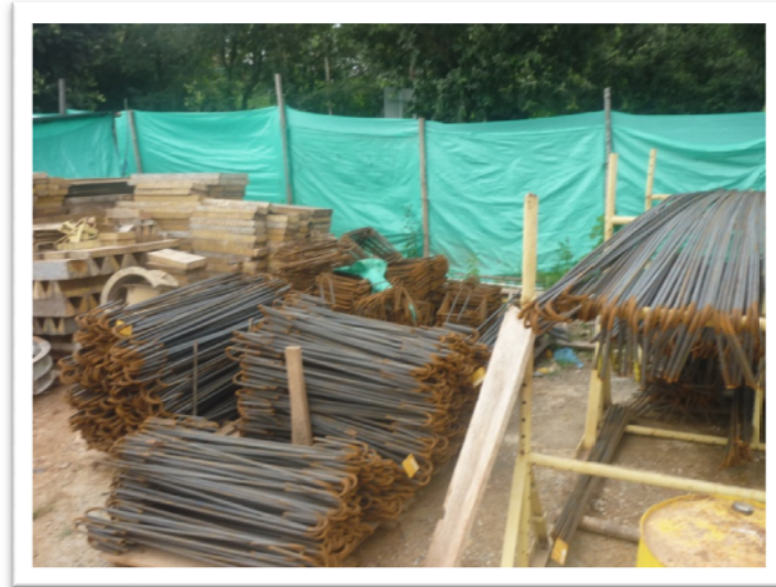
Figura 22. Acero de refuerzo cimentación torres 1 y 2
