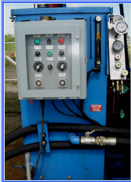
Figura 27. Tanque de aceite.
