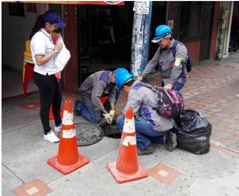
Figura 27. Levantamiento de canalización barrio La Universidad.
