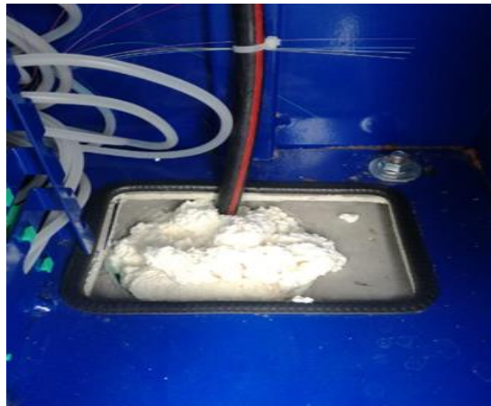
Figura 37. Espuma de polietileno en entrada de GO.
