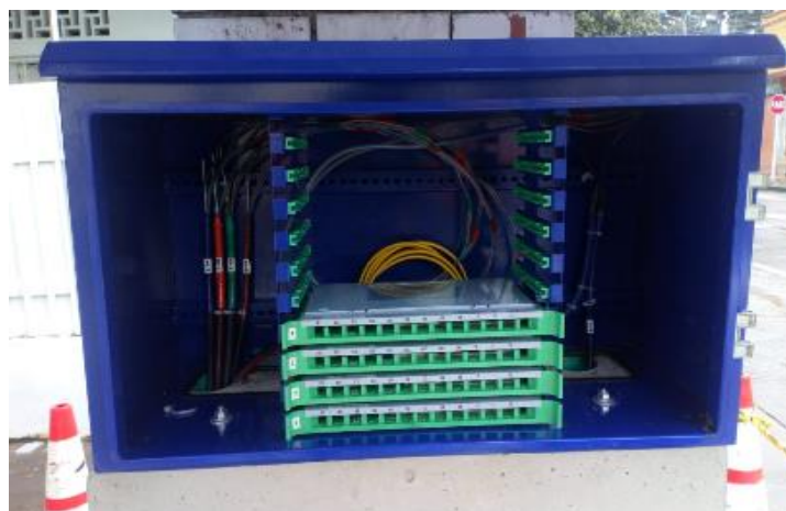
Figura 17. Ubicación de bandejas dentro de un GO.
