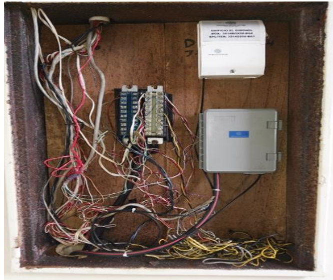
Figura 38. Correcta instalación de elementos con pita guía.
