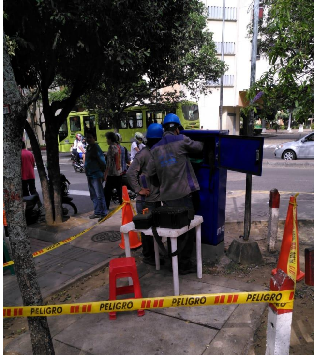
Figura 40. Zona de trabajo correctamente demarcada.
