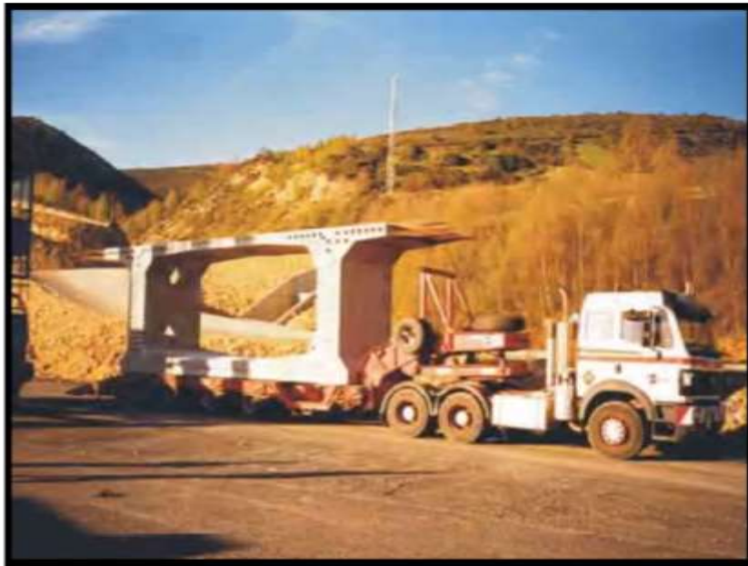
Figura 23 Transporte de una dovela prefabricada.
