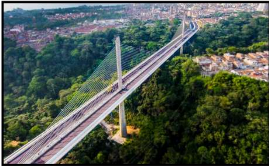
Figura 11: Viaducto de la Novena.
