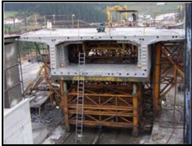
Figura 21 Control geométrico de dovela recién fabricada.
