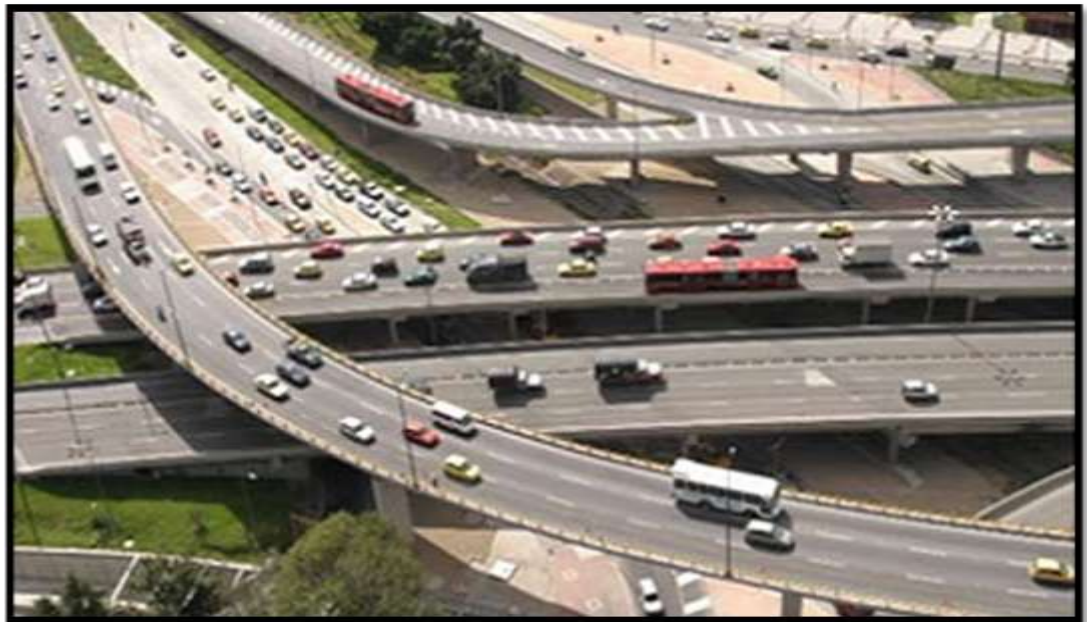
Figura 3: Puente tercer nivel calle 92
