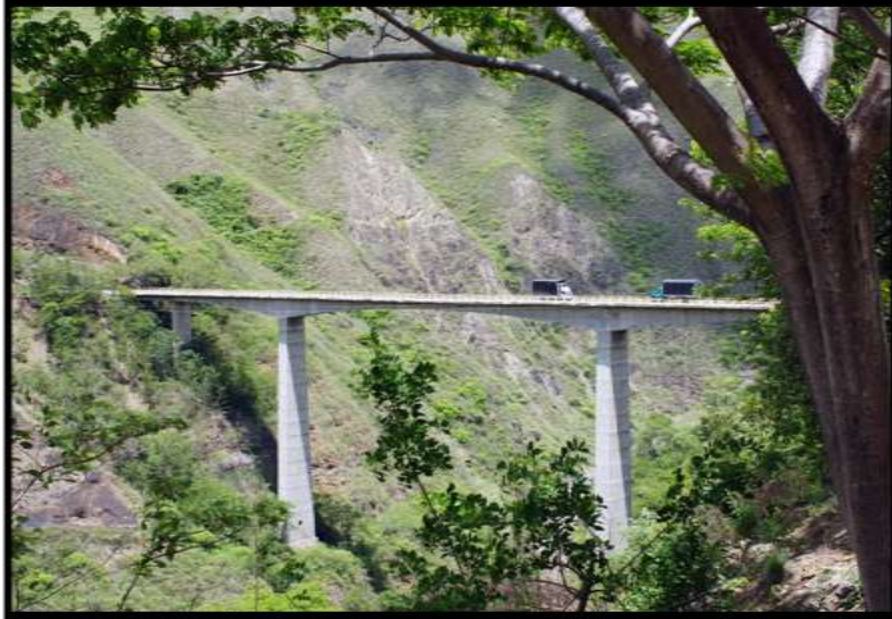
Figura 1: Puente voladizos sucesivos sobre río Juanambú, Chachagüí, Nariño
