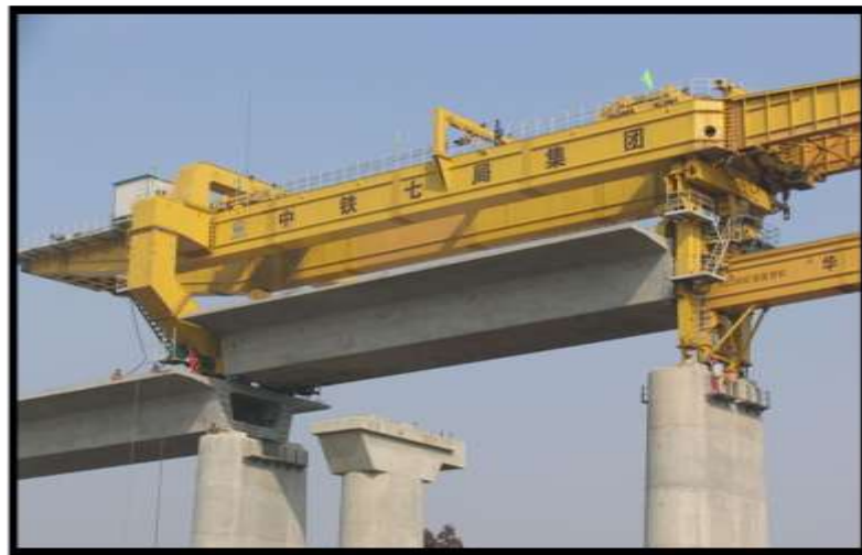
Figura 14: Instalación de dovelas vano a vano mediante cimbra.
