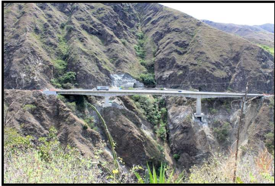
Figura 2: Puente tramo Cisneros-Loboguerrero, vía Buga-Buanaventura, Valle del Cauca.
