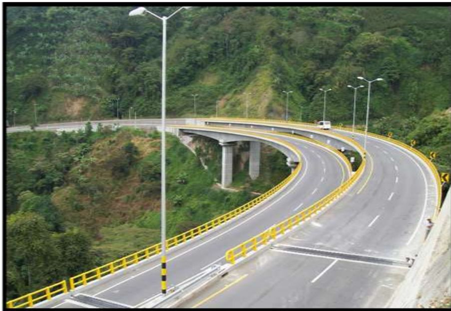
Figura 8: Viaducto la Estampilla.
