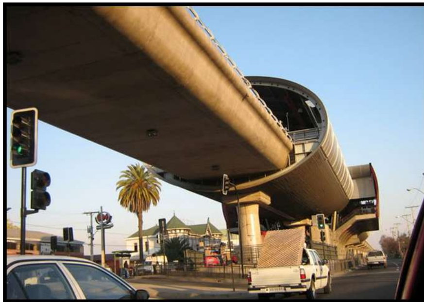
Figura 15: Puente de la Línea 4 del metro de Chile.
