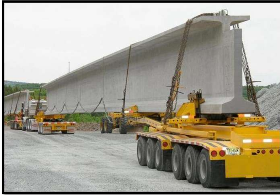
Figura 22: Transporte de una viga prefabricada.
