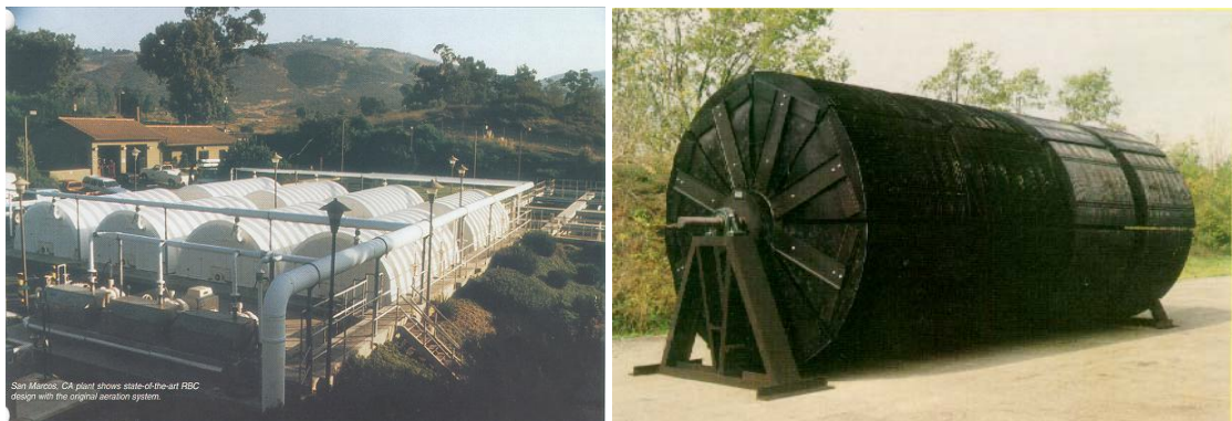
Figura 12. Sistema de tratamiento con RBC.
