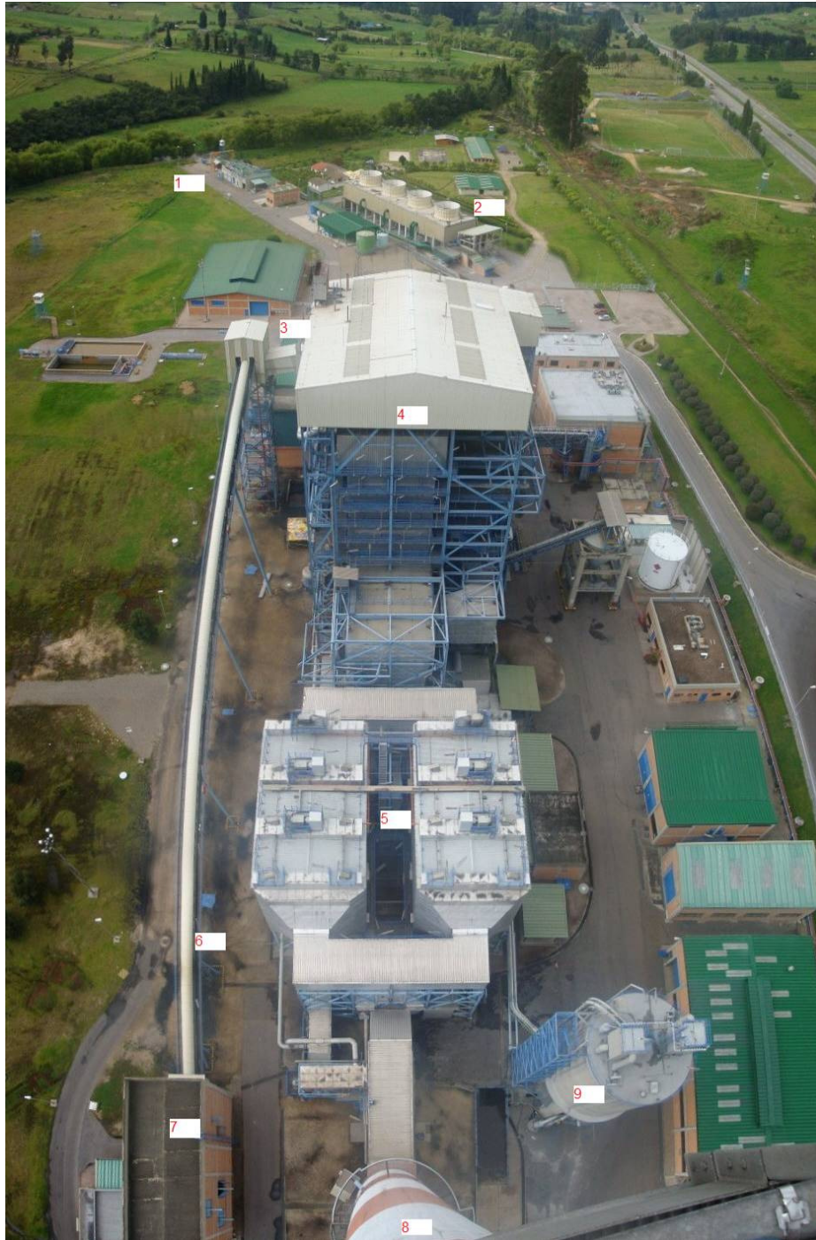
Figura 5. Panorámica Termopaipa IV: 1 Planta tratamiento agua – 2 Torres Enfriamiento – 3 Turbogrupos – 4 Caldera – 5 Precipitador electrostático – 6 Banda transportadora carbón – 7 Edificio trituración carbón – 8 Chimenea – 9 Silo ceniza.
