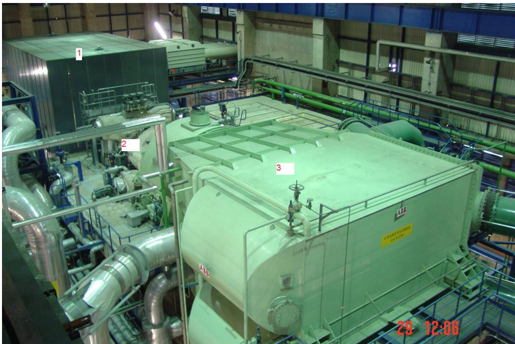
Figura 17. Casa de Máquinas: 1 – Generador, 2 – Turbina, 3 – Condensador
