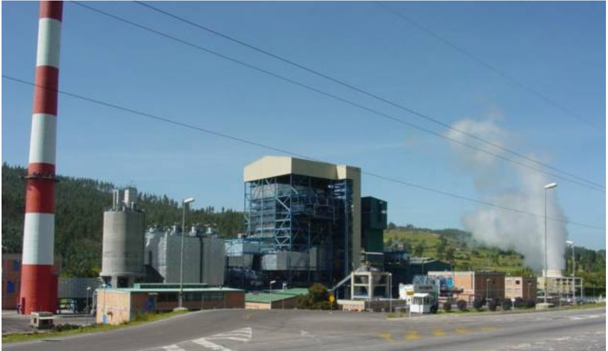
Figura 2. Vista panorámica de la planta Termopaipa IV.
