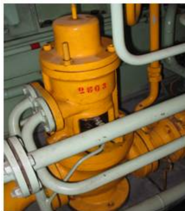
ELECTRIFICADORA DE SANTANDER. Manual de operación de la Unidad Turbogas N°3. Bucaramanga 2006.
