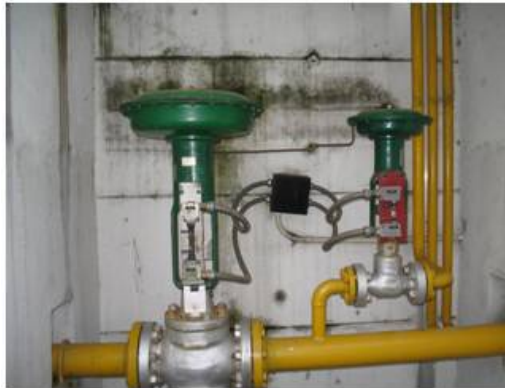
ELECTRIFICADORA DE SANTANDER. Manual de operación de la Unidad Turbogas N°3. Bucaramanga 2006.
