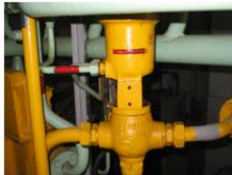
ELECTRIFICADORA DE SANTANDER. Manual de operación de la Unidad Turbogas N°3. Bucaramanga 2006.
