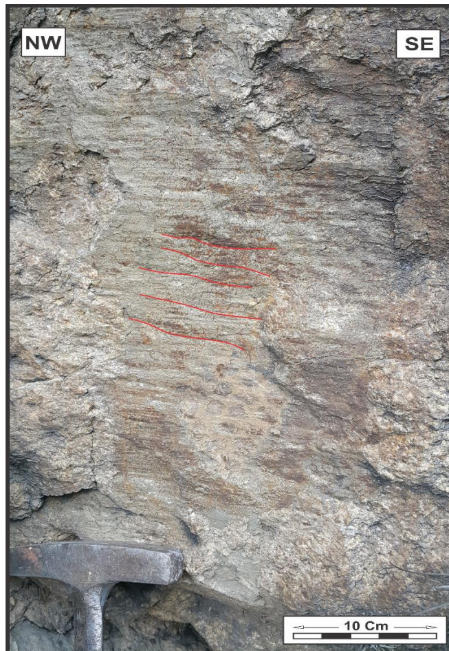
Figura 21. Estrías de falla presentes dentro de la Cuarzo-diorita en el Km 45+519 en la vía Aguas claras- Rio de Oro.
