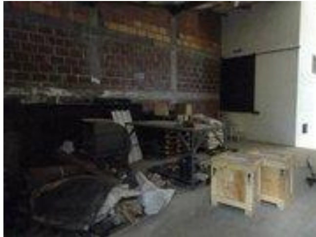
Figura 25. Área de mantenimiento.
