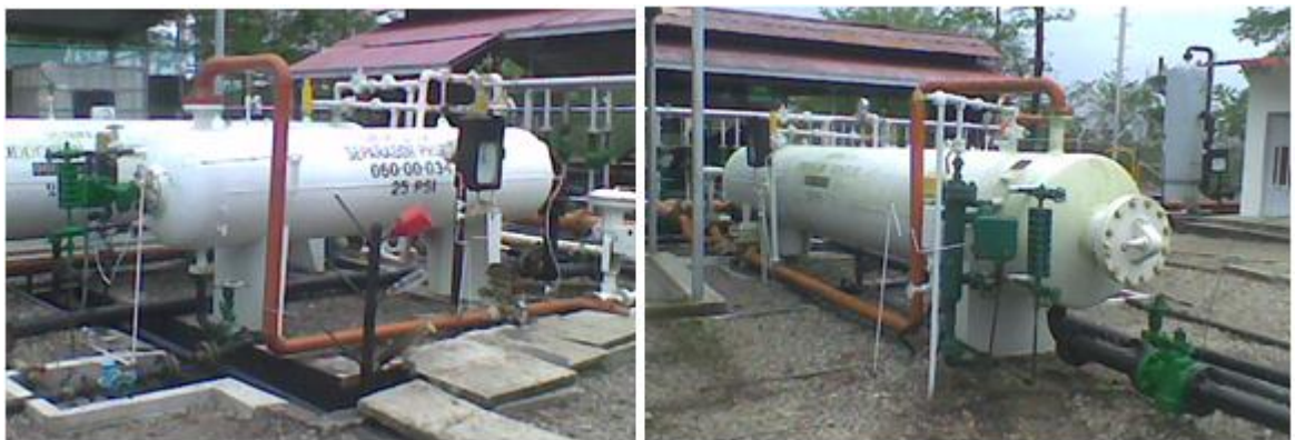
Figura 48. Separadores de prueba y general Estación Bonanza 2009
