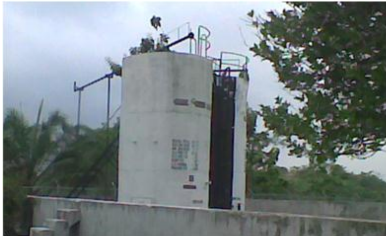
Figura 49. Tanques de prueba A y B de 250 BPD Estación Bonanza 2009
