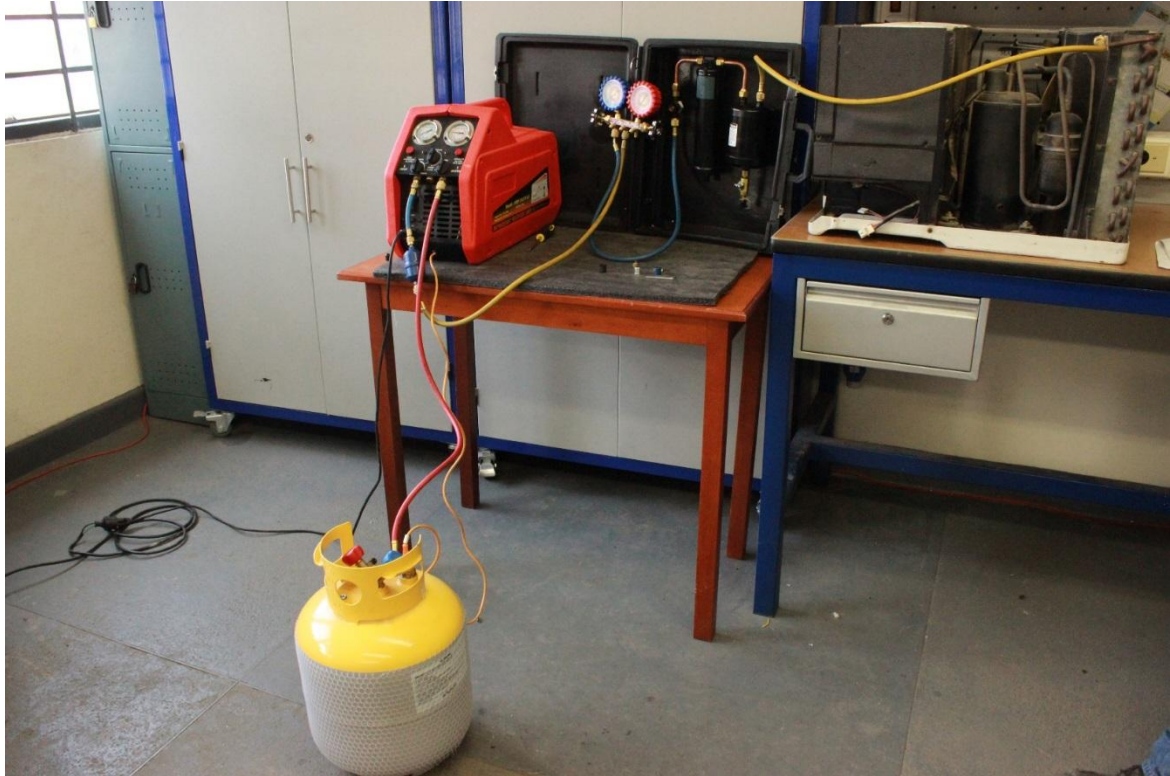
Figura 87. Conexiones en el proceso de recuperación de refrigerante
