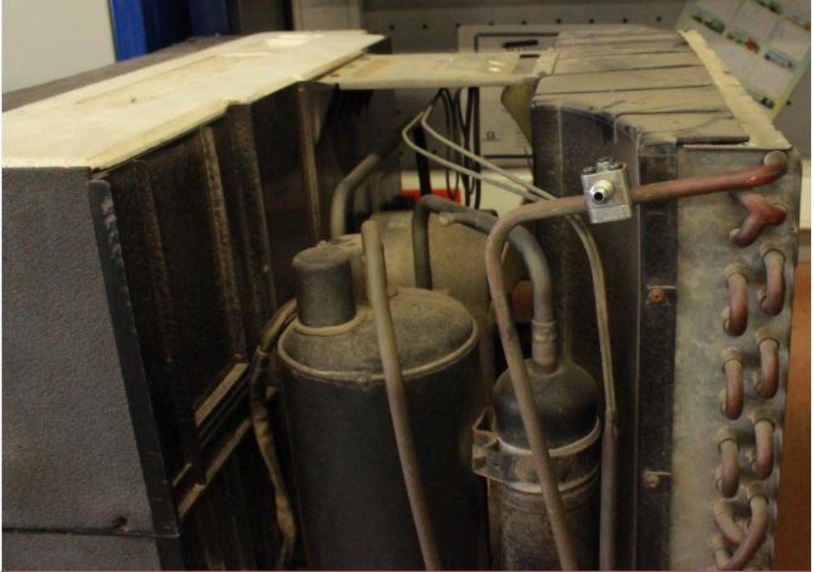
Figura 23. Conexión de la válvula perforadora
