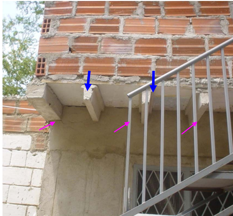
Figura 4-20 Ver vigueta tipo T Fuente Grupo INME.
