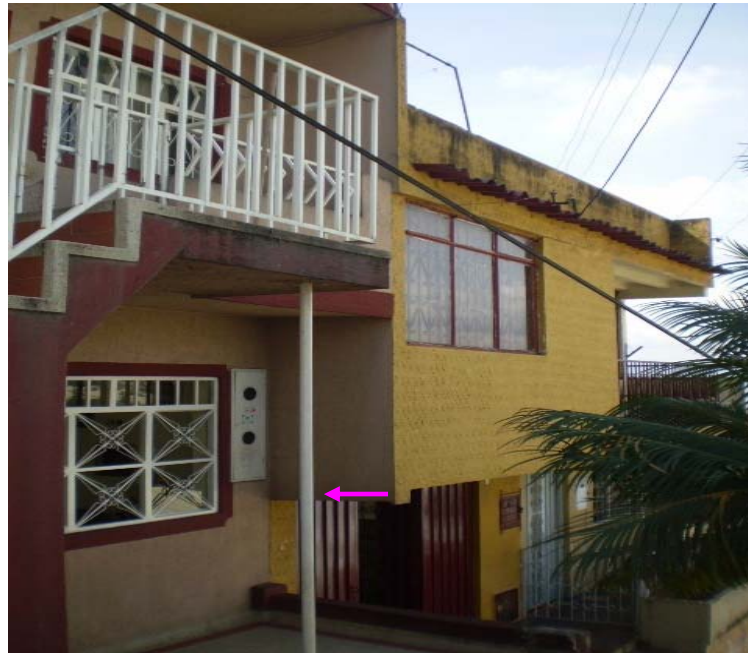
Figura 4-12 Ver apoyo externo metálico.
