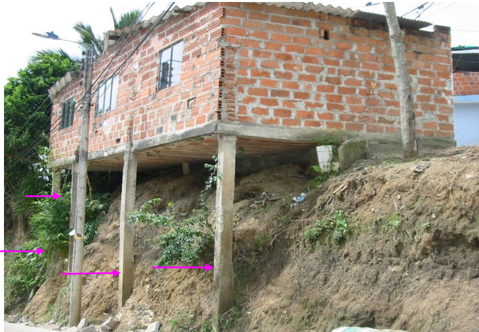
Figura 4-3 Cimentación en Zancos.
