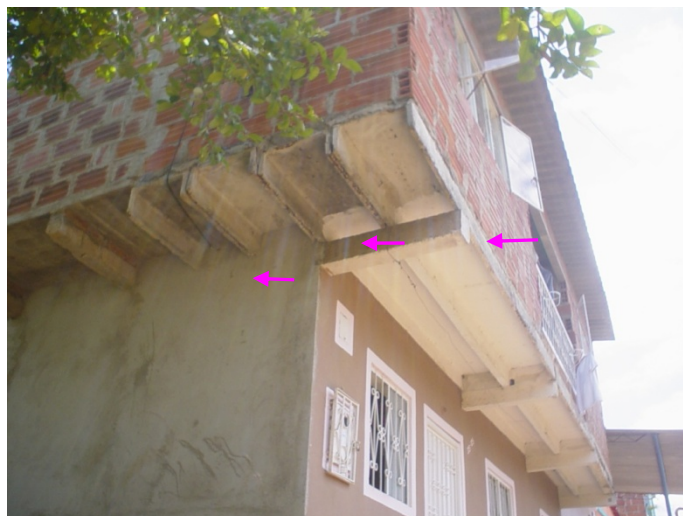
Figura 4-18 Ver vigas canaleta.
