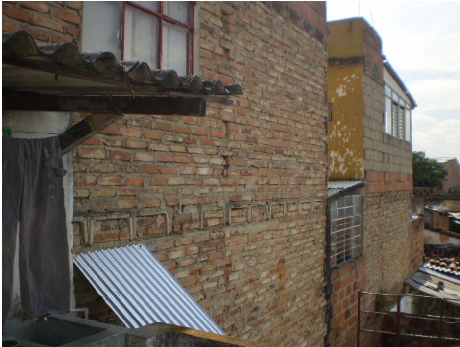
Figura 5-2 Muro de carga lateral.
