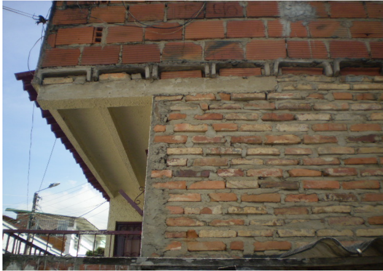
Figura 5-5 Vigüeta de apoyo para voladizo.
