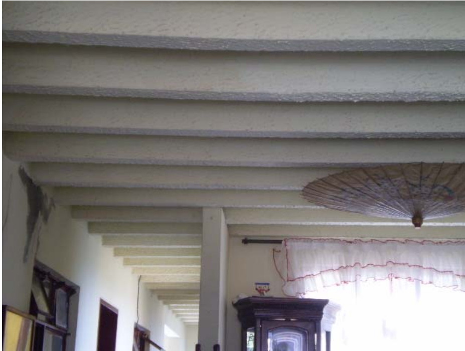
Figura 5-3 Viguetas prefabricadas tipo bovedilla. Fuente Archivo personal.
