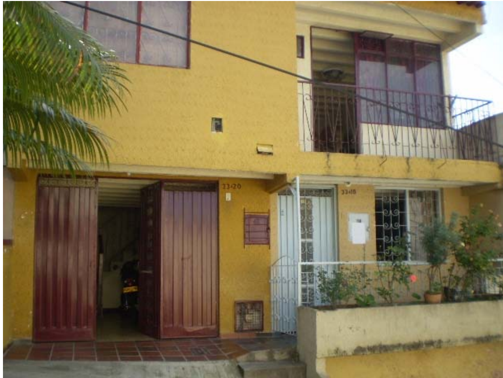
Figura 5-1 Vista general de vivienda a modelar.
