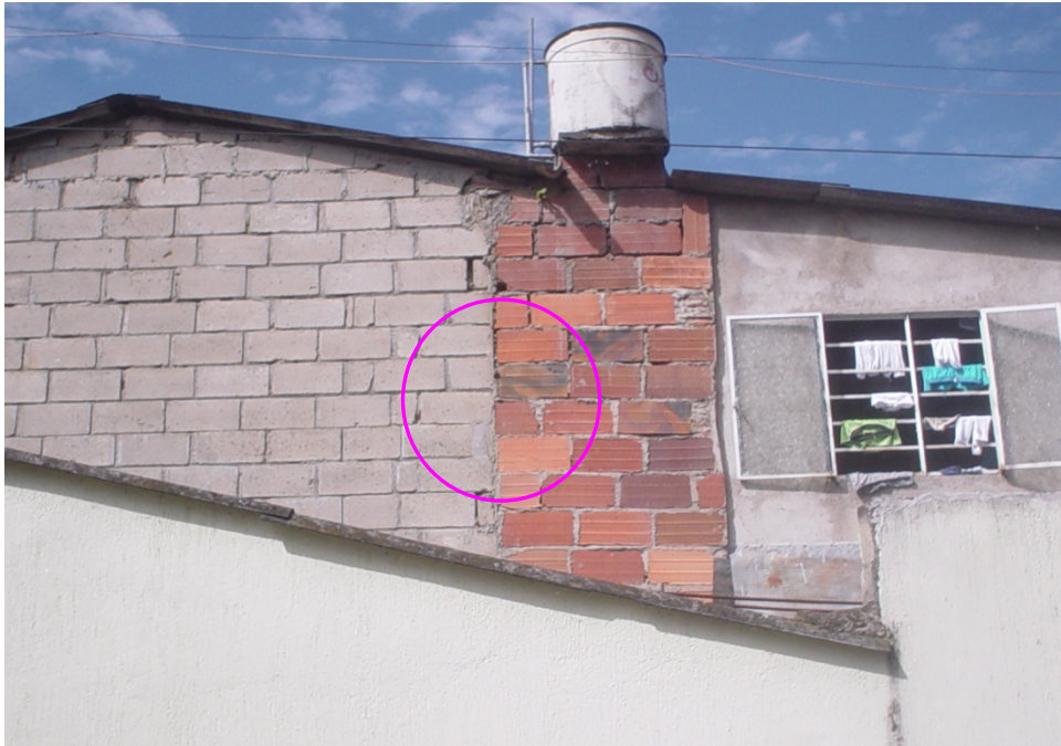
Figura 4-6 Dos tipos de mampostería, en un mismo muro.
