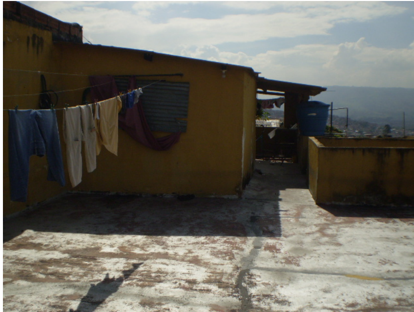
Figura 5-4 Elementos de gran peso en terraza. Fuente Archivo personal.
