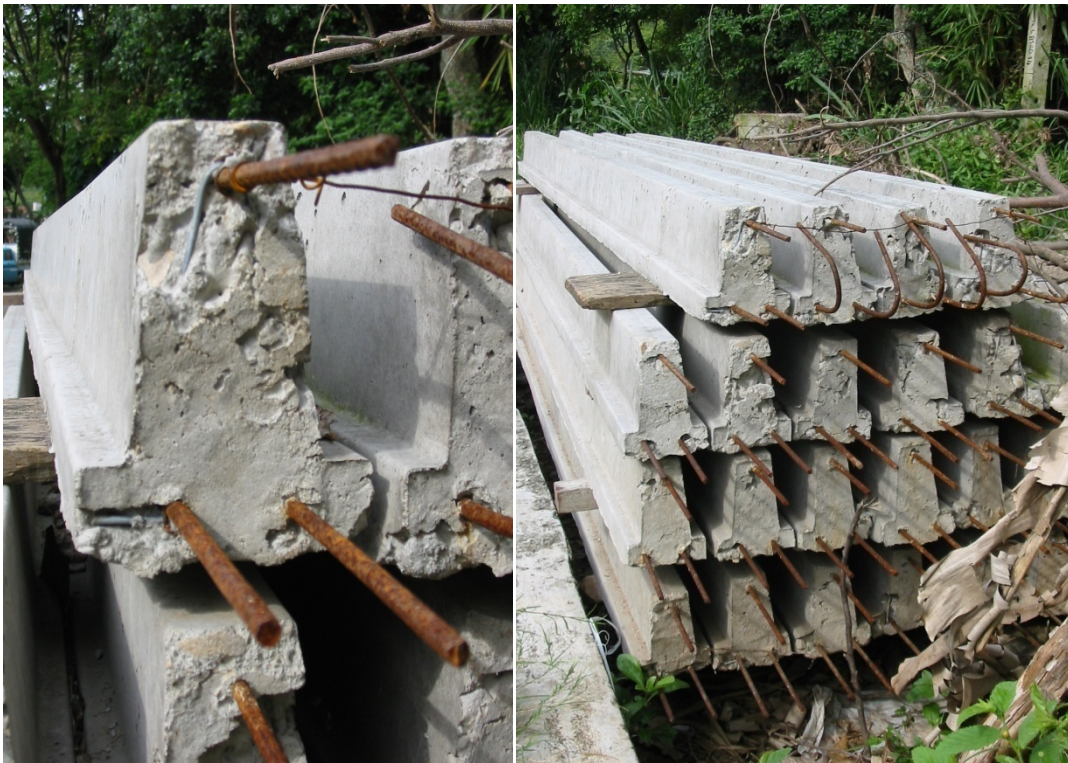
Figura 4-19 Viguetas Tipo T.
