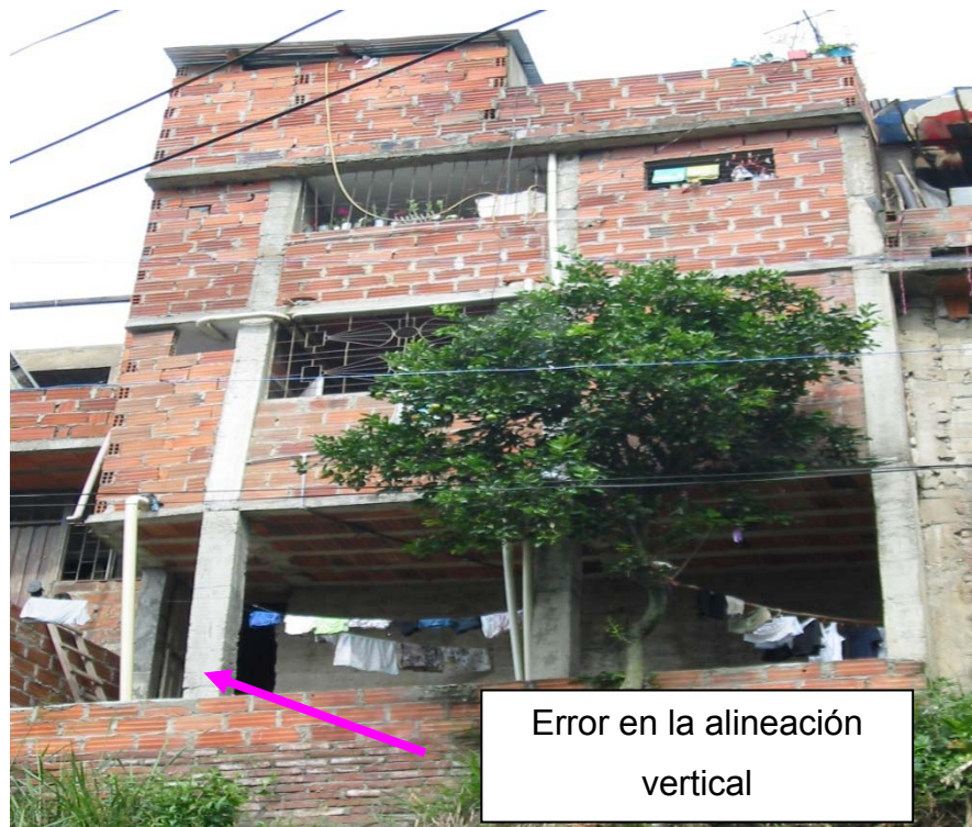
Figura 4-9 Mala alineación de columna.
