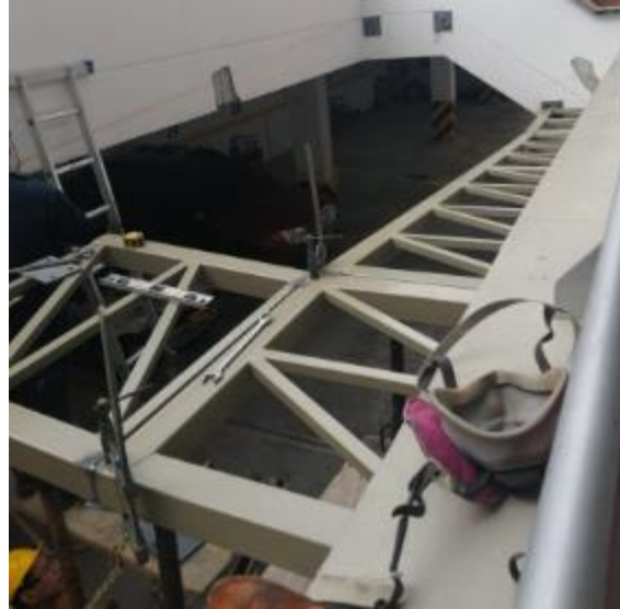
Figura 19. Detalle rampa de acceso en proceso de construcción
