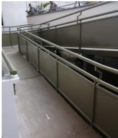
Figura 20. Rampa de acceso terminada
