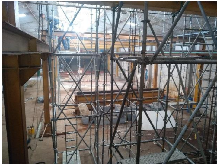
Figura 17. Detalle armado de andamios para desmonte de puente grúa
