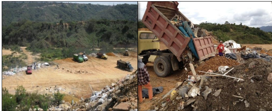
Fotografía 11. Descargue de material que ingresa en los vehículos
