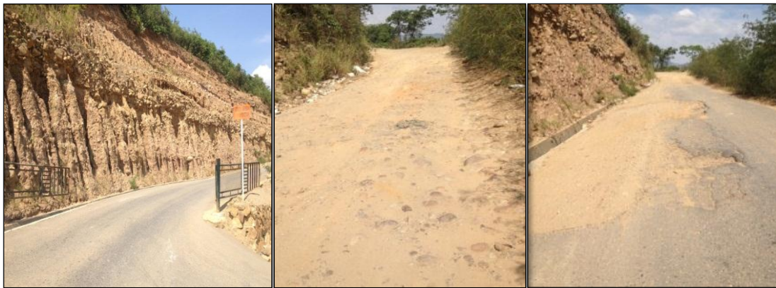
Fotografía 4. Vía interna principal Botadero de tierra el parque
