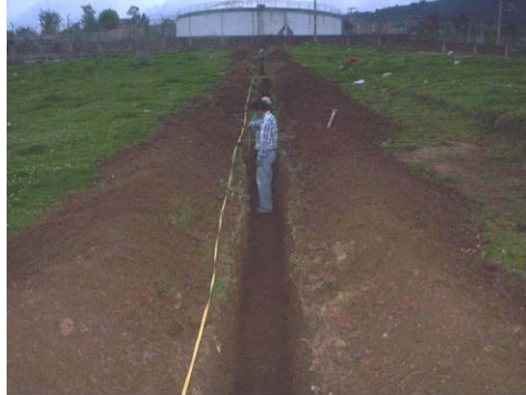
Figura 19. Excavación Manual Material Común, Barrio Divino Niño.
