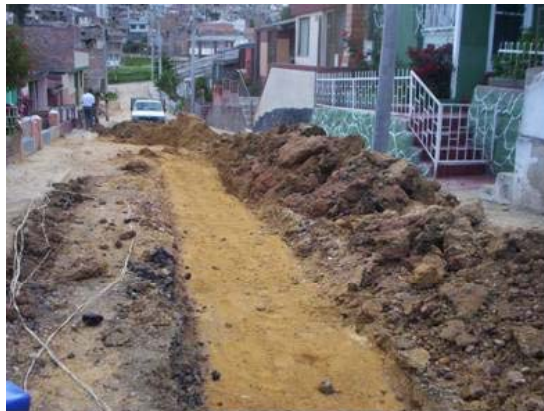
Figura 10. Relleno Recebo Compactado Barrio Los Alcázares.
