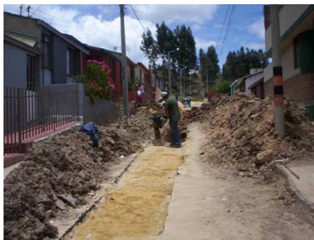
Figura 8. Compactación Mecánica Barrio Los Alcázares.
