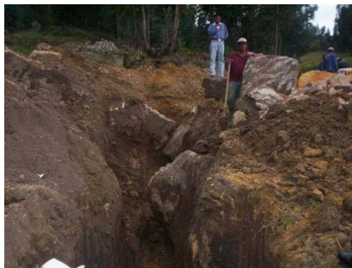
Figura 11. Excavación en Roca Barrio Primero de Mayo.
