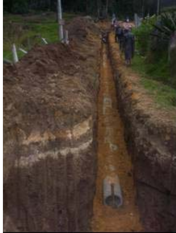
Figura 12. Instalación Tubería 12" Solado y Atraque en Recebo Compactado, Barrio Primero de Mayo.
