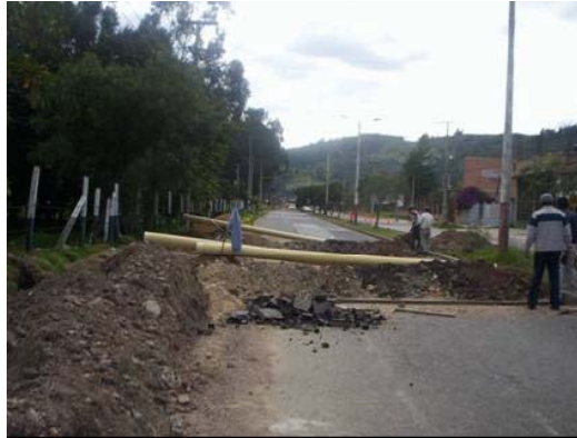
Figura 15. Obras de Drenaje de Aguas Lluvias, Diferentes Sectores de la Ciudad.
