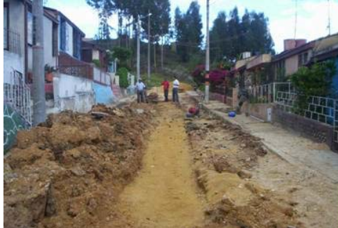
Figura 9. Relleno Recebo Compactado Barrio Los Alcázares.
