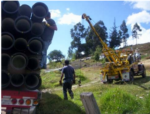
Figura 21. Descargue Tubería HD 12"
