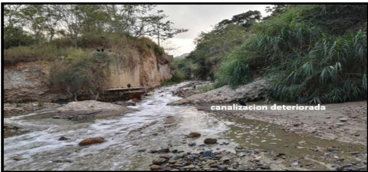
Figura 33. Estructura realizada en ciclópeo para la mitigación de la velocidad del cauce de la quebrada la Rosita, erosionado y destruido, X:1'100.880,532 m Y:1'276.662,736 m H: 679 m.s.n.m (Ver Apéndice G.)
