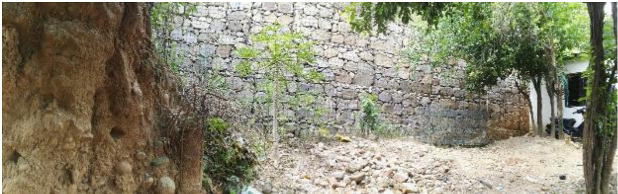
Figura 18. Muro de gaviones construido por la CDMB luego del deslizamiento del 2005, junto con vegetación.
