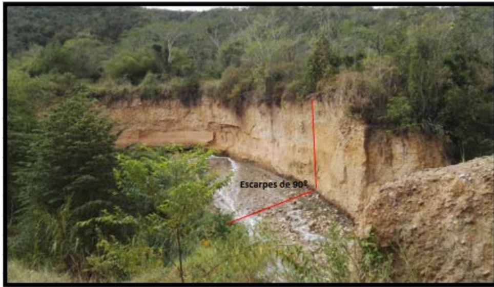
Figura 37. El cauce con los escarpes adyacentes forma una figura de L con un ángulo de 90^\circ , el escarpe alcanza una altura aproximada de hasta 20 m. X: 1'101.865,792, Y: 1'276.541,069, H: 700 m.s.n.m.
