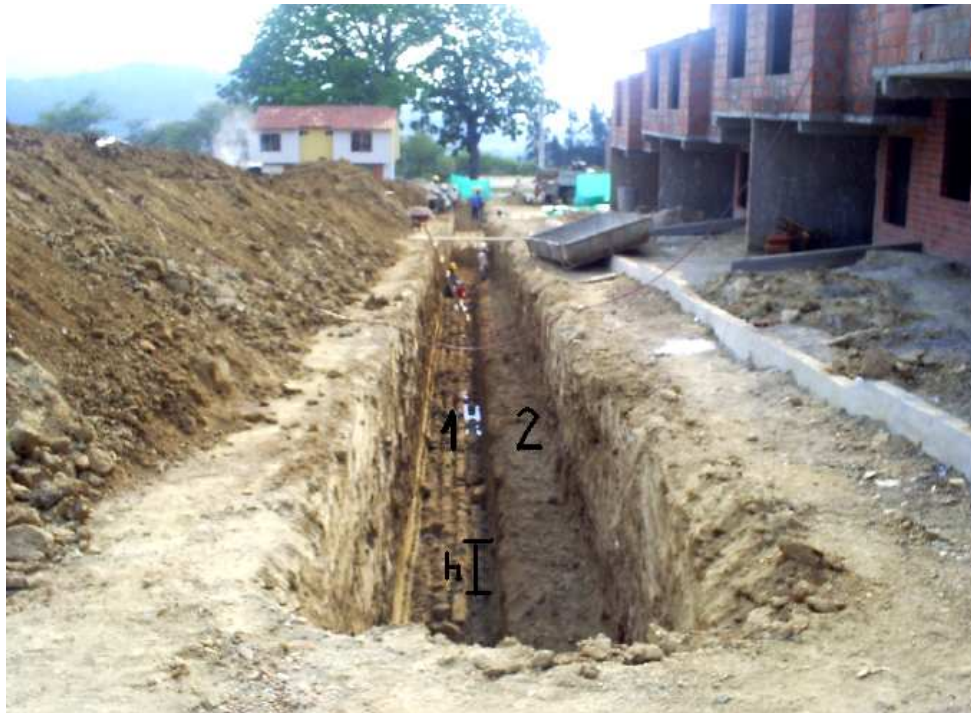
Ilustración 2 Actividades del Alcantarillado.
