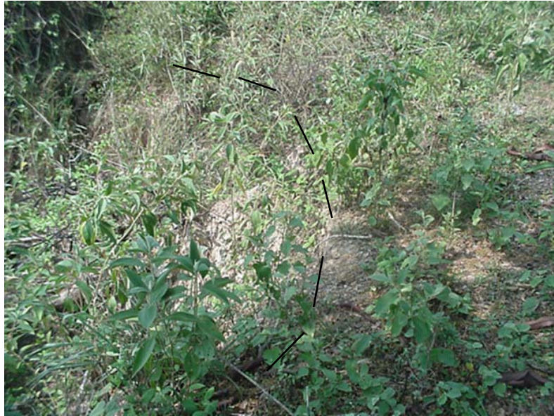
Fotografía 9. Se observa formación de cárcava en el rebose de invierno del estanque para cría de peces.
