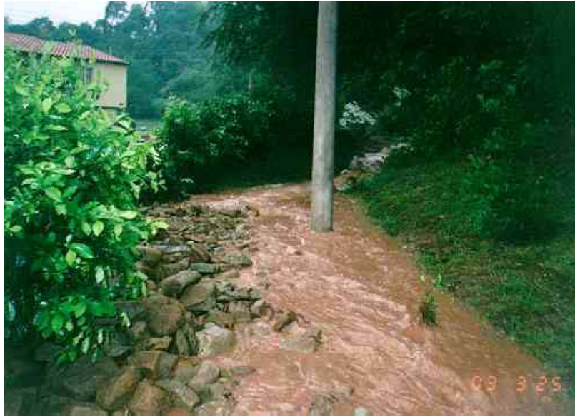
Fotografía 5. Se observa la zona de captación de la quebrada durante la época invernal de 2003 (vista desde la calle 62).
