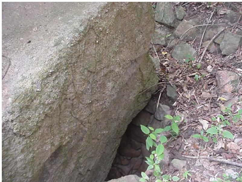
Fotografía 10. Vista de pozo abandonado para captación de agua.
