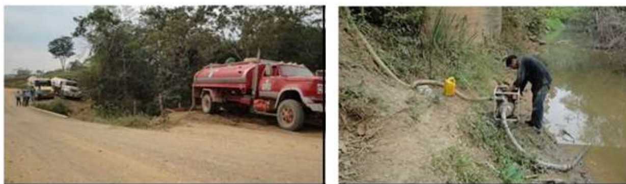
Figura 40. Abastecimiento de agua en carrotanques a través de 2 motobombas (Fuente: ANLA)
