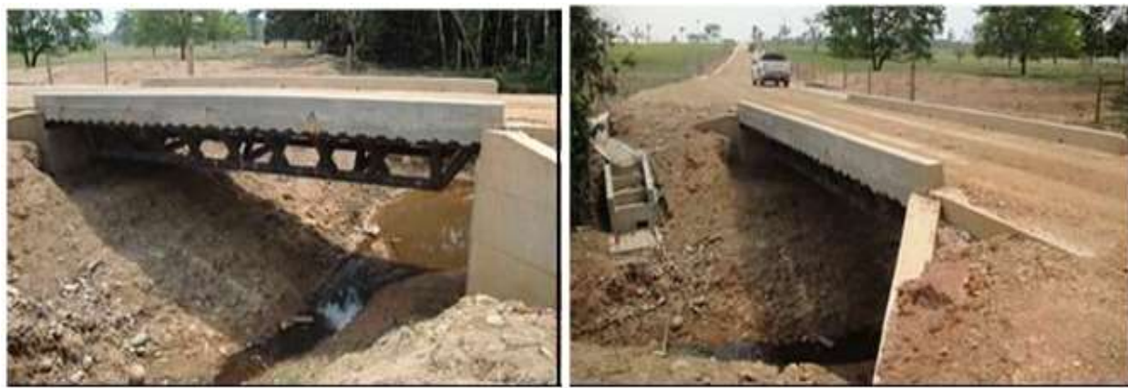
Figura 41. Estructura en hierro y concreto del puente (Fuente: ANLA)
