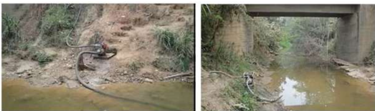
Figura 39. Ubicación de las motobombas en el lecho de la quebrada la Guadalosa (Fuente: ANLA)
