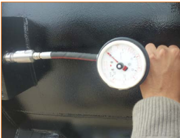
Momento en que se inicia la prueba, verificando que el equipo de adherencia se encuentra en cero. Fuente: Autor.
