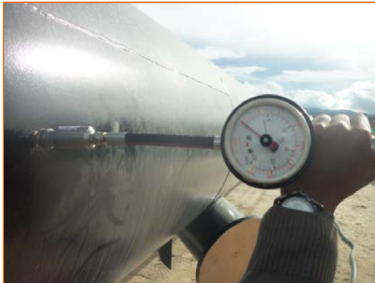
Momento al iniciar prueba, verificando que el equipo de adherencia se encuentra en cero. Fuente: Autor.
