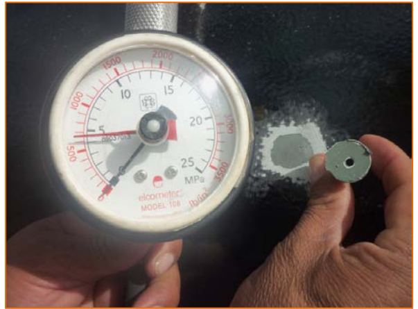
Fotografía N° 33, de la Prueba N° 05
