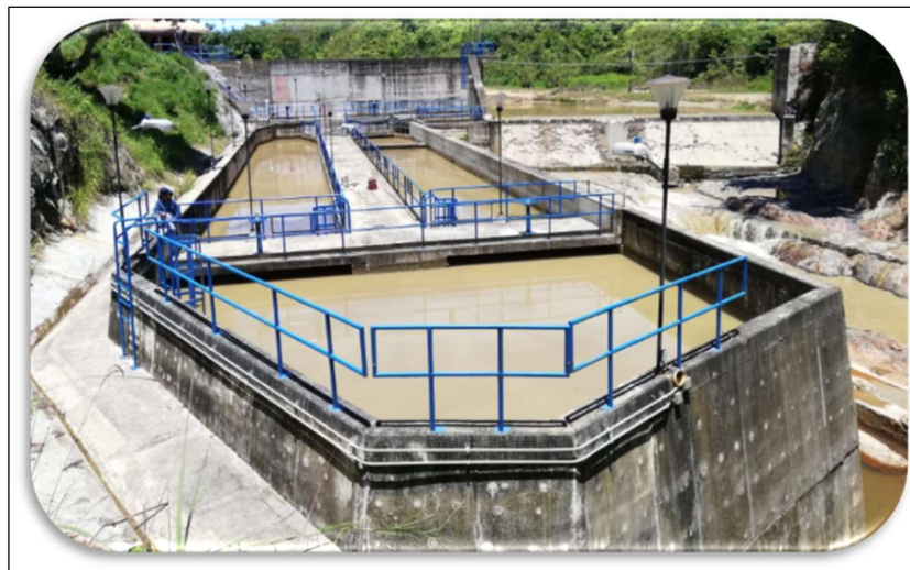
Figura 3. Pequeña Central Hidroeléctrica Doña Teresa.
