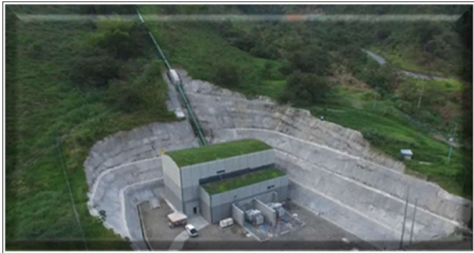
Figura 4. Pequeña Central Hidroeléctrica El Edén.
