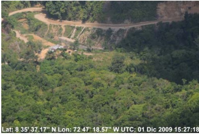
Fotografía 28. Zona de erosión en zona escarpada.
