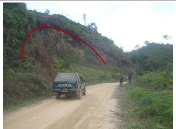
Fotografía 19 Corona de deslizamiento
