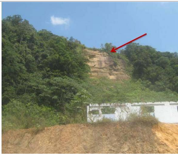
Fotografía 16 Escarpe en Roca. (D2)
