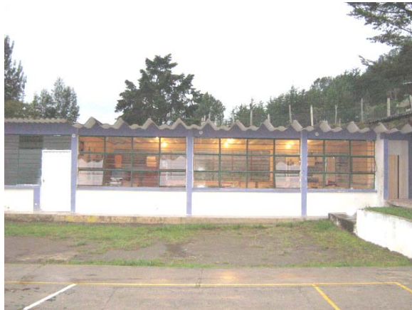
Figura N° 8 Vista de Frente de Ventanales
