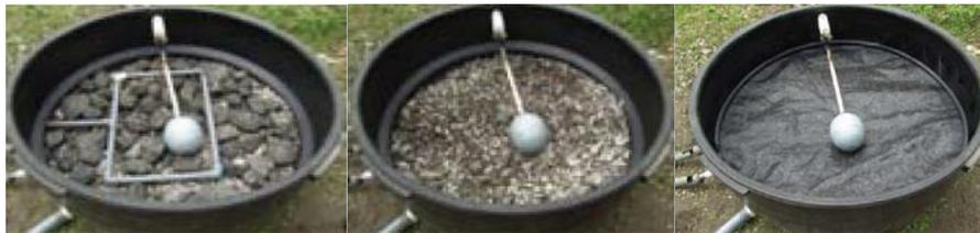
Figura 3-7. marco colector de líquido hacia RM
