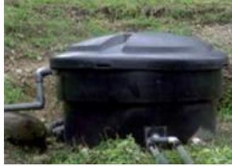
Figura 3-5 . Recamara de dosificación en polietileno de 250 litros de capacidad.
