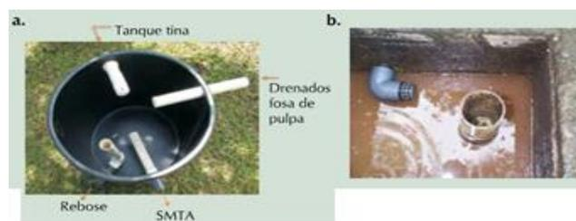
Figura 3- 1. trampa de pulpas: a. polietileno b. mampostería
