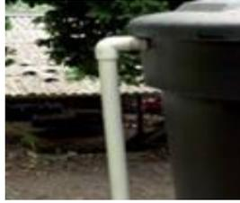
*Figura 3- 4* tubería de seguridad para rebose de fondos y descarga de lodos
